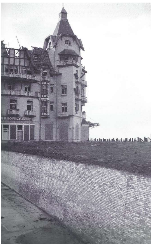
Figuur 25 : zicht op antitankgracht op het Albertplein (nr. 8 op fig. 24) (uit Lambrecht 2017, p. 189).
