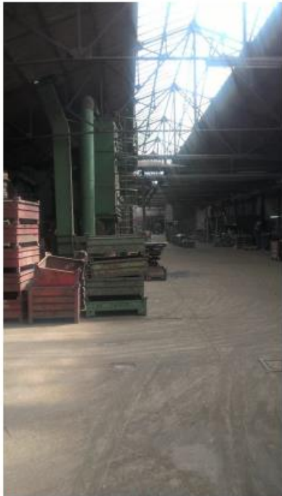
Hangar met achteraan verfspuitplaats
