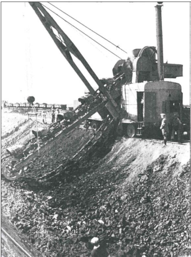
Figuur 105: Graafwerken voor een antitankgracht met baggermolen. Via een smalspoor wordt de afgegraven aarde weggevoerd. (Bron: JACQUES, F. 2017: bijlage b3.1a).
