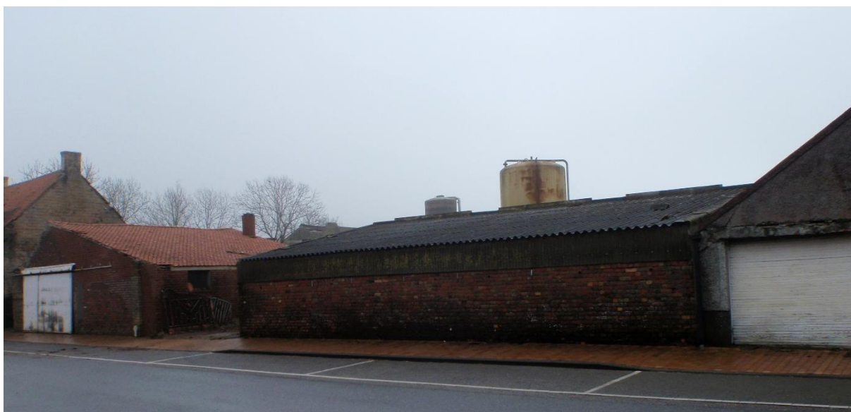
Foto 4: Links gebouw 4 en rechts gebouw 5 gezien vanaf de Hemmestraat (© J. Verrijckt Bvba)
