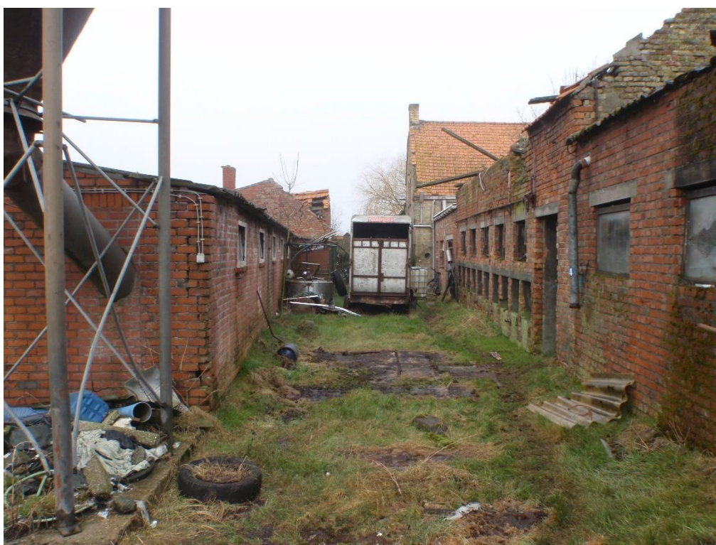
Foto 2: Links gebouw 4 en rechts gebouw (© J. Verrijckt Bvba)
