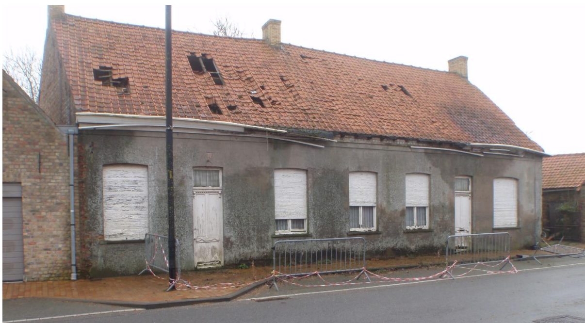
Foto 1: Gebouw 1 gezien vanaf de Hemmestraat (© J. Verrijckt Bvba)
