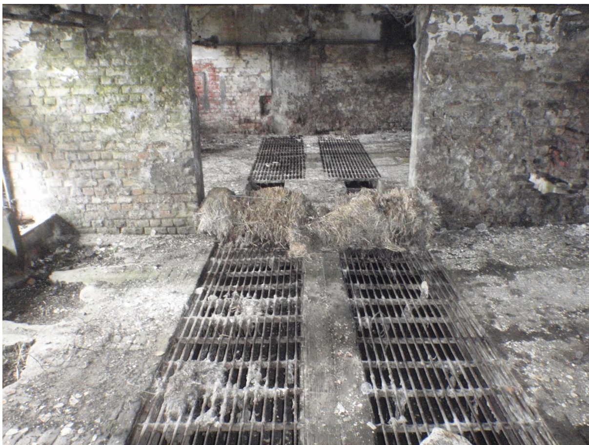
Foto 3: Open vloerstructuur en mestkuil in gebouw 2 en 3 (© J. Verrijckt Bvba)
