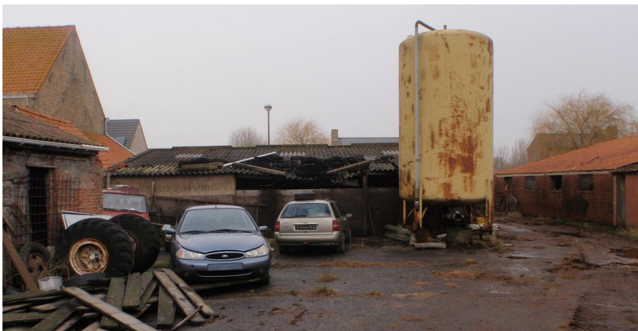
Foto 6: Links gebouw 5 en rechts gebouw 4 (© J. Verrijckt Bvba)
