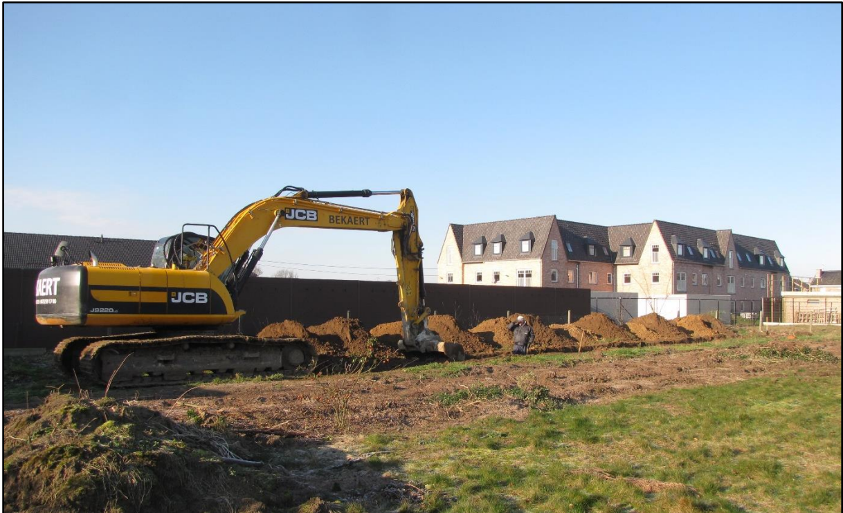
Figuur 7 Overzichtsfoto van de aanleg van sleuf 5 in het westelijke deel.
