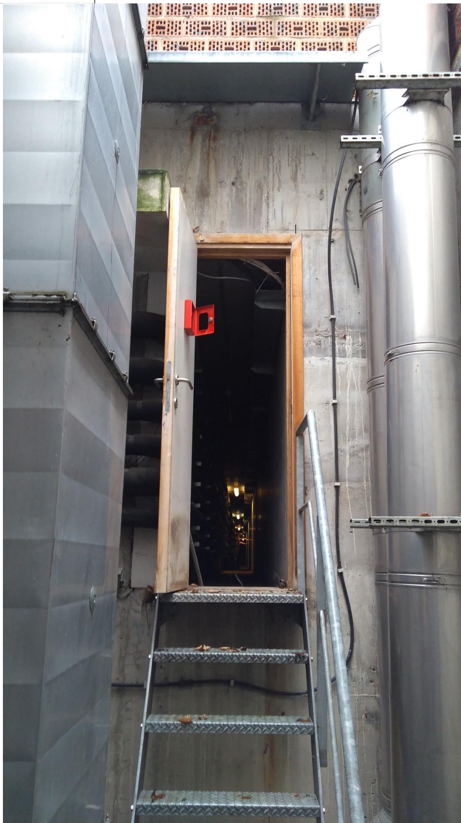
Figuur 44: De ondergrondse gang voor technieken
