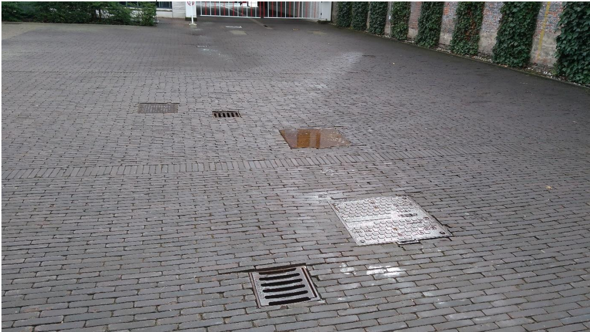
Figuur 45: Zicht op de koer met ondergrondse nutsleidingen en -putten
