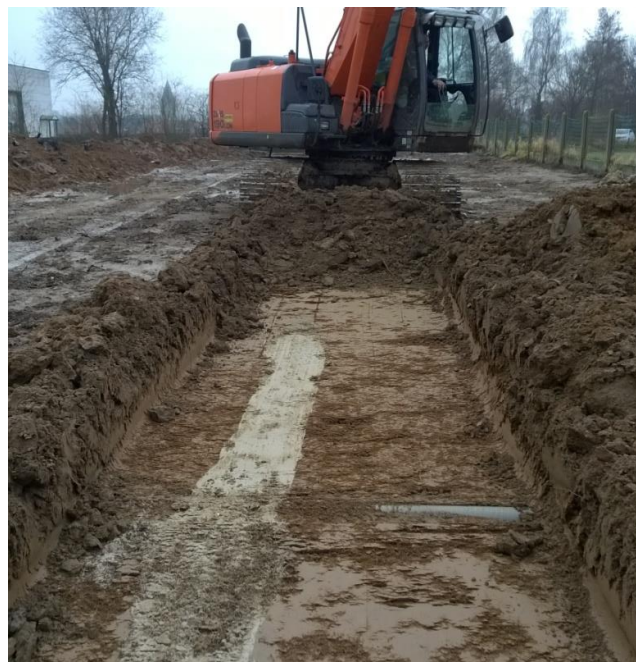
Figuur 51. Verstoring proefsleuf 2
