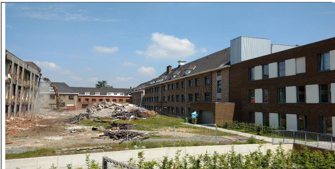
Figuur 4: Foto van afbraakwerken van de bestaande blok A (Boeckx Architects 2016)
