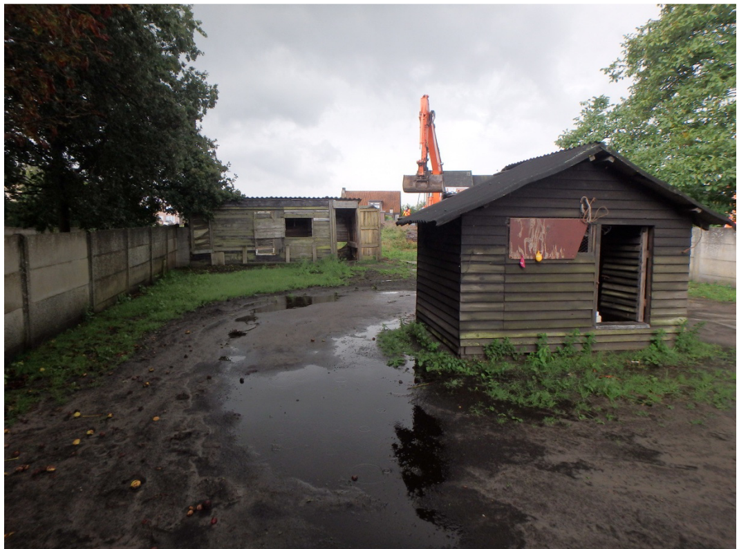
Afb. 20. Schuurtjes ter hoogte van een geplande sleuf.
