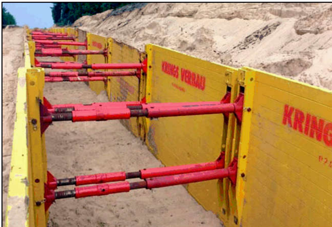
Afbeelding 1: Typevoorbeeld van kringbeschoeiing.
