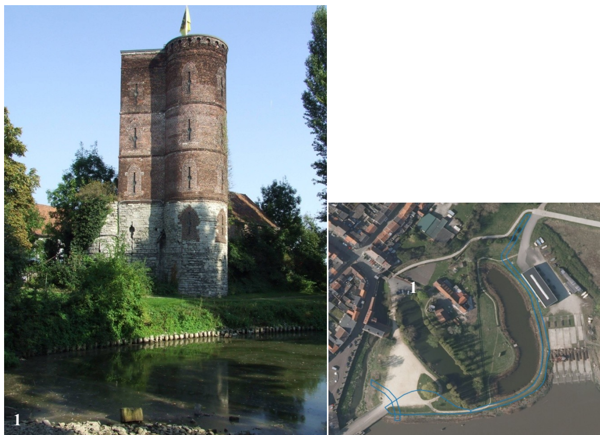
Fig. 2. Foto-impressie van het plangebied, deel 1 (Foto's: R. Paulussen & A. Van de Water, 14-9-2016).
