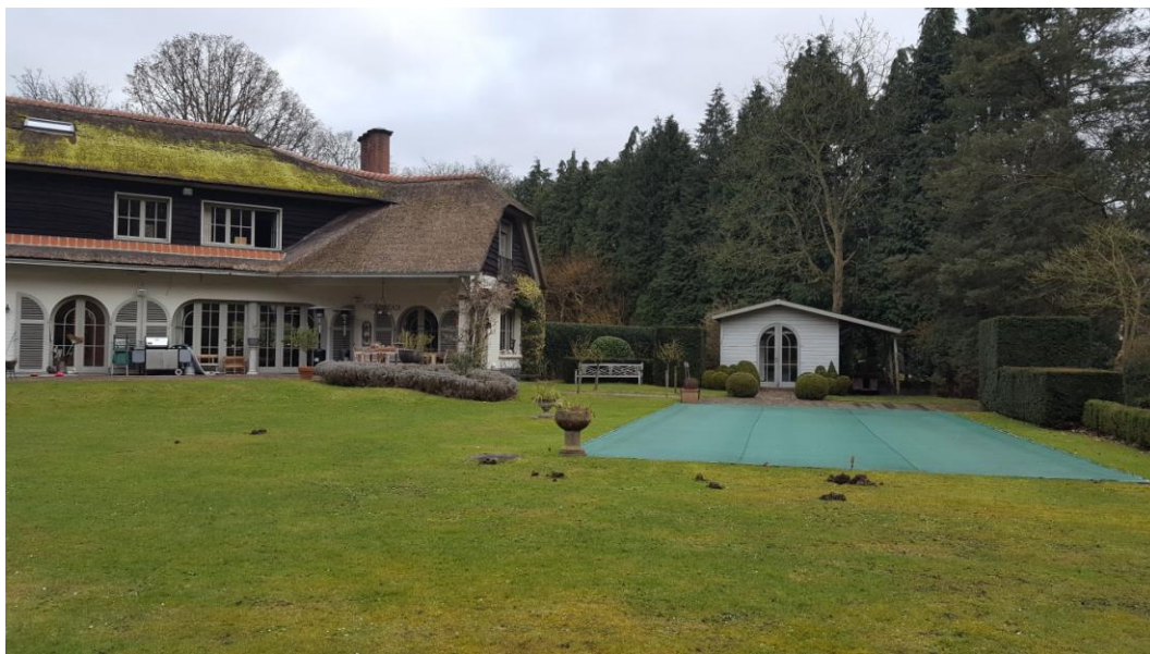
Afb. 8. Foto van de huidige bebouwing en zwembad. Foto genomen aan achterzijde van het gebouw. 3
