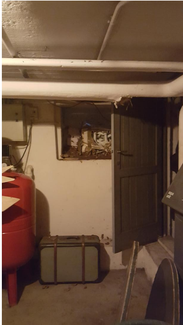
Afb. 5. Foto van de kelder huidig woongebouw. 2
