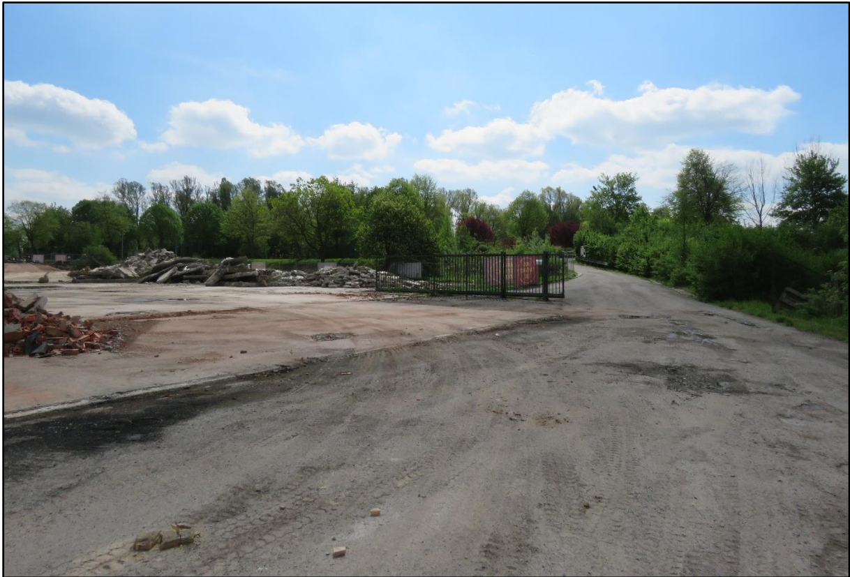
Figuur 2 Foto dd. 23/04/2018 vanuit het noorden, met zicht op de toegangsweg rechts en de bodemplaat op de plek van het afgebroken fabriekspand.
