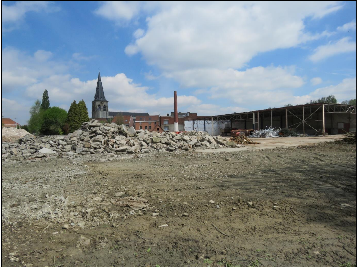
Figuur 4 Foto dd. 23/04/2018 vanuit het zuiden op het oostelijk deel van het plangebied, met zicht op gerooide groenzone en de plek van het afgebroken fabriekspand.
