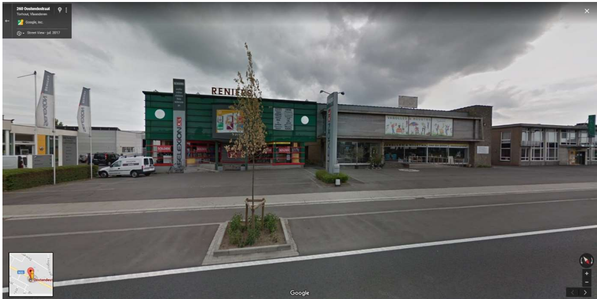
Figuur 7 : Zicht op de bestaande, af te breken toestand (© Google Street View).
