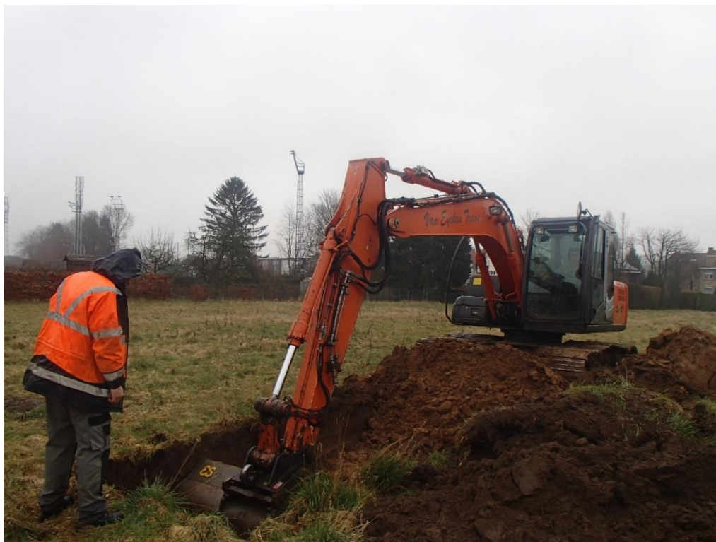
Foto 2: Aanleg werkput 2 met kraan op rupsbanden in het westen van het plangebied (© BAAC Vlaanderen)
