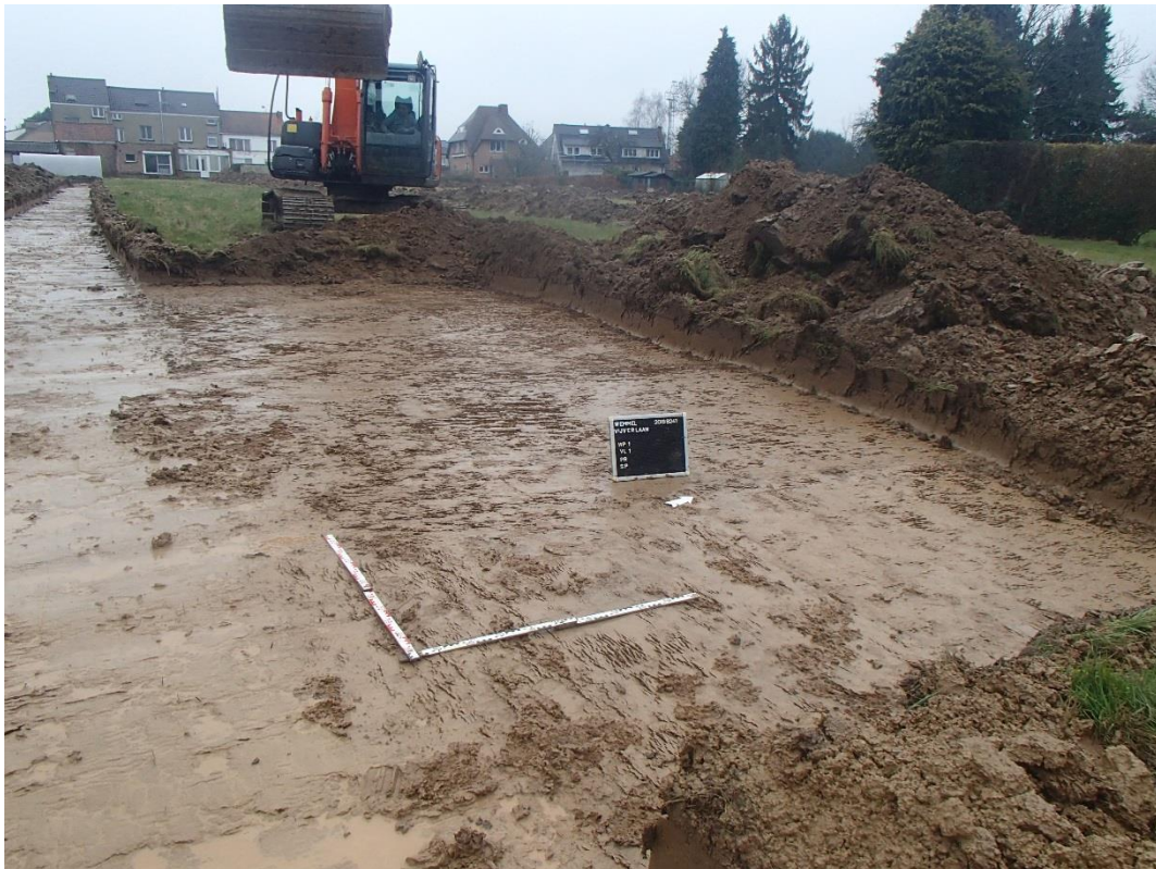
Foto 7: Kijkvenster aangelegd aan het begin van werkput 1.
