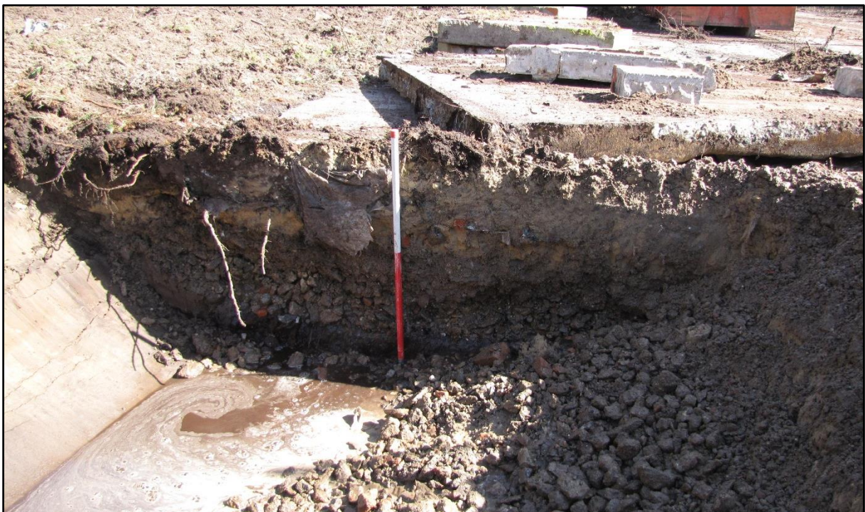
Figuur 7 Steenslagfundering onder de betonplaat van de toegangsweg tot minstens 1m diep onder het huidige maaiveldniveau.
