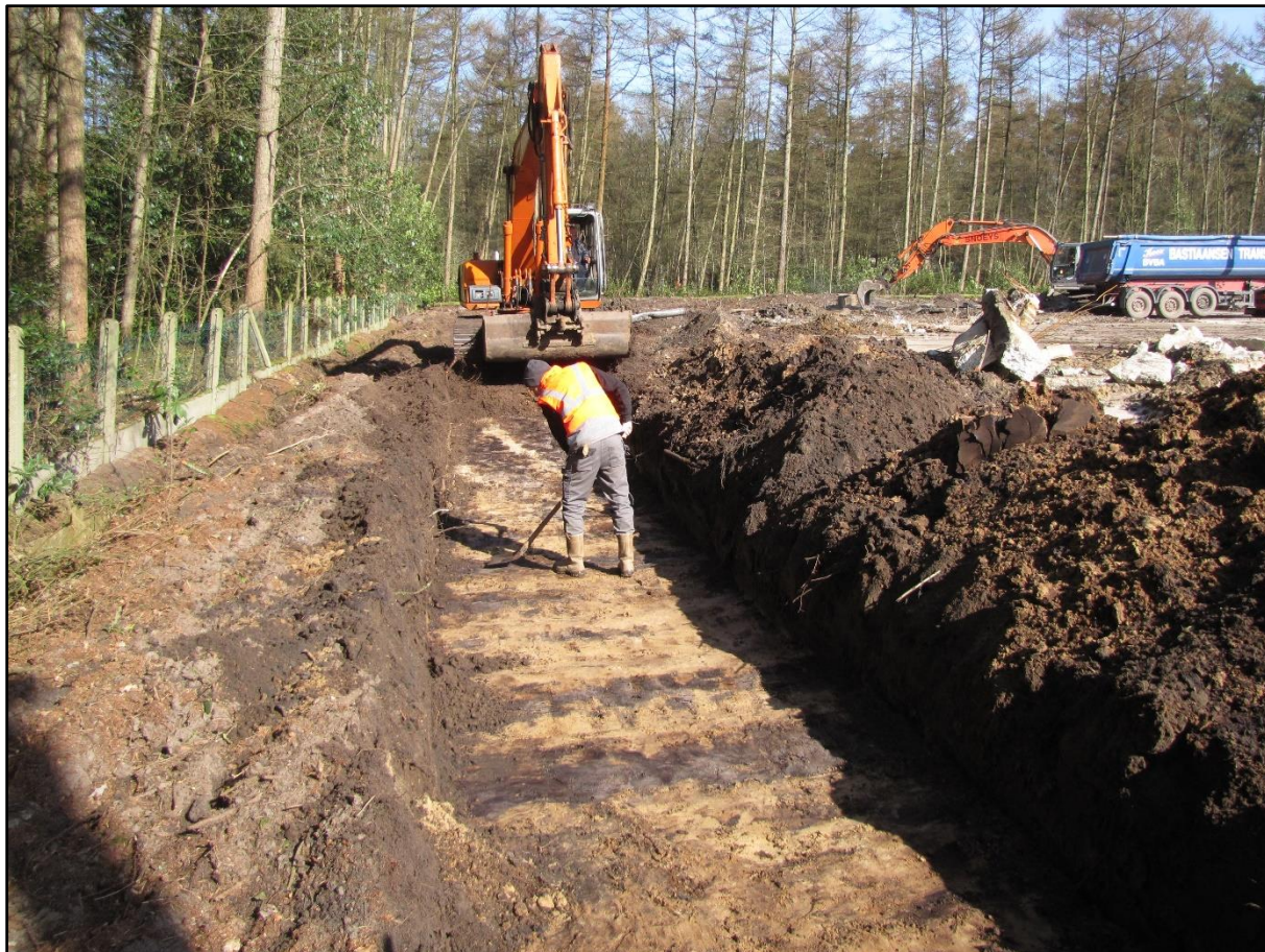
Figuur 10 Sfeerbeeld tijdens de aanleg van sleuf 5 aan de westelijke zijde van het plangebied met zicht op de parallelle bosbouwgreppels.
