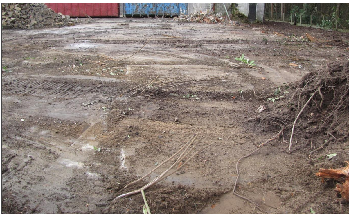
Figuur 5 Zicht op de betonnen vloerplaat van het magazijn/tankstation met een vierkant rasterpatroon van 3 x 3m met sleuffunderingen bestaande uit gewapend beton.
