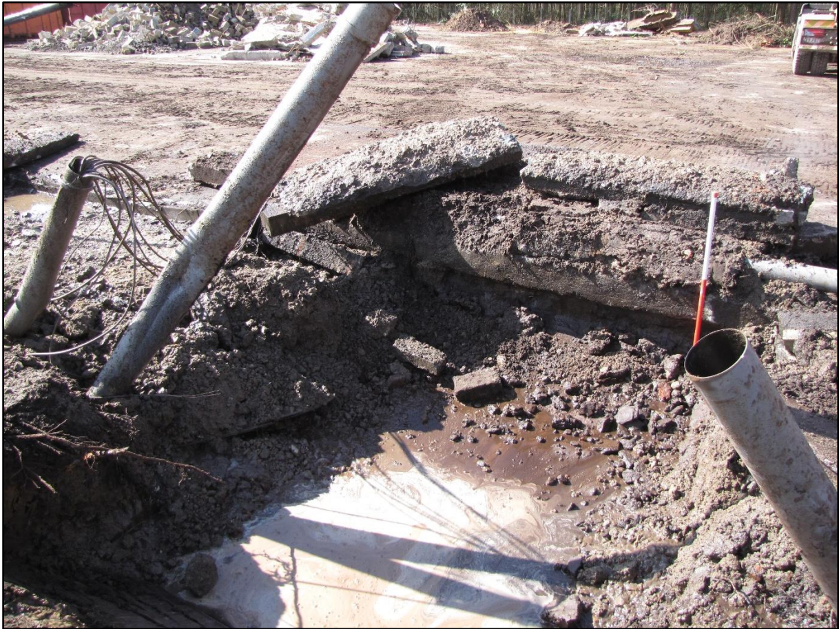
Figuur 6 Betonplaat, steenslag en nutsvoorzieningen ter hoogte van het magazijn/tankstation.
