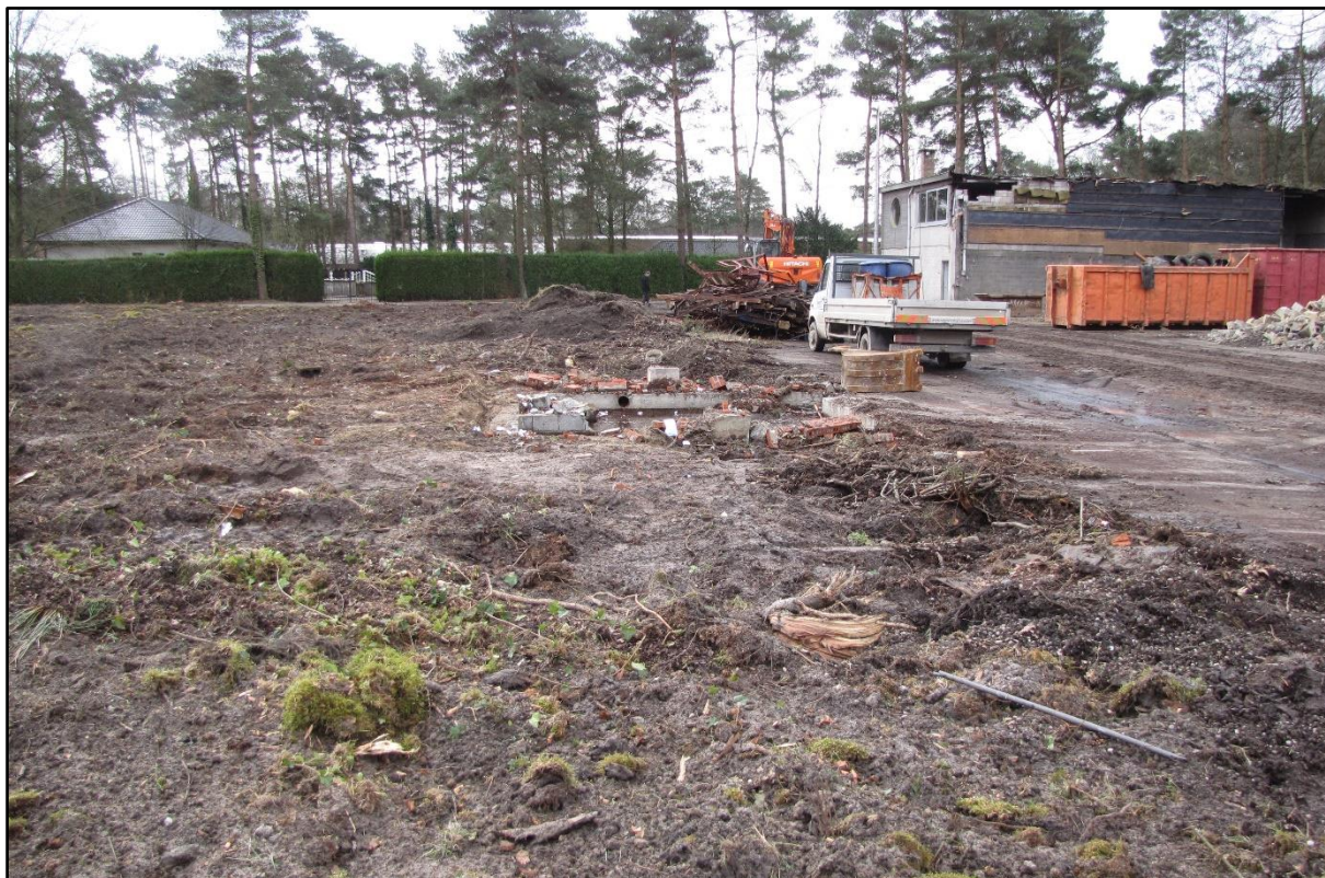
Figuur 4 Zicht op de verhardingen, het grote magazijn/tankstation en de locatie van de ondergrondse structuren.
