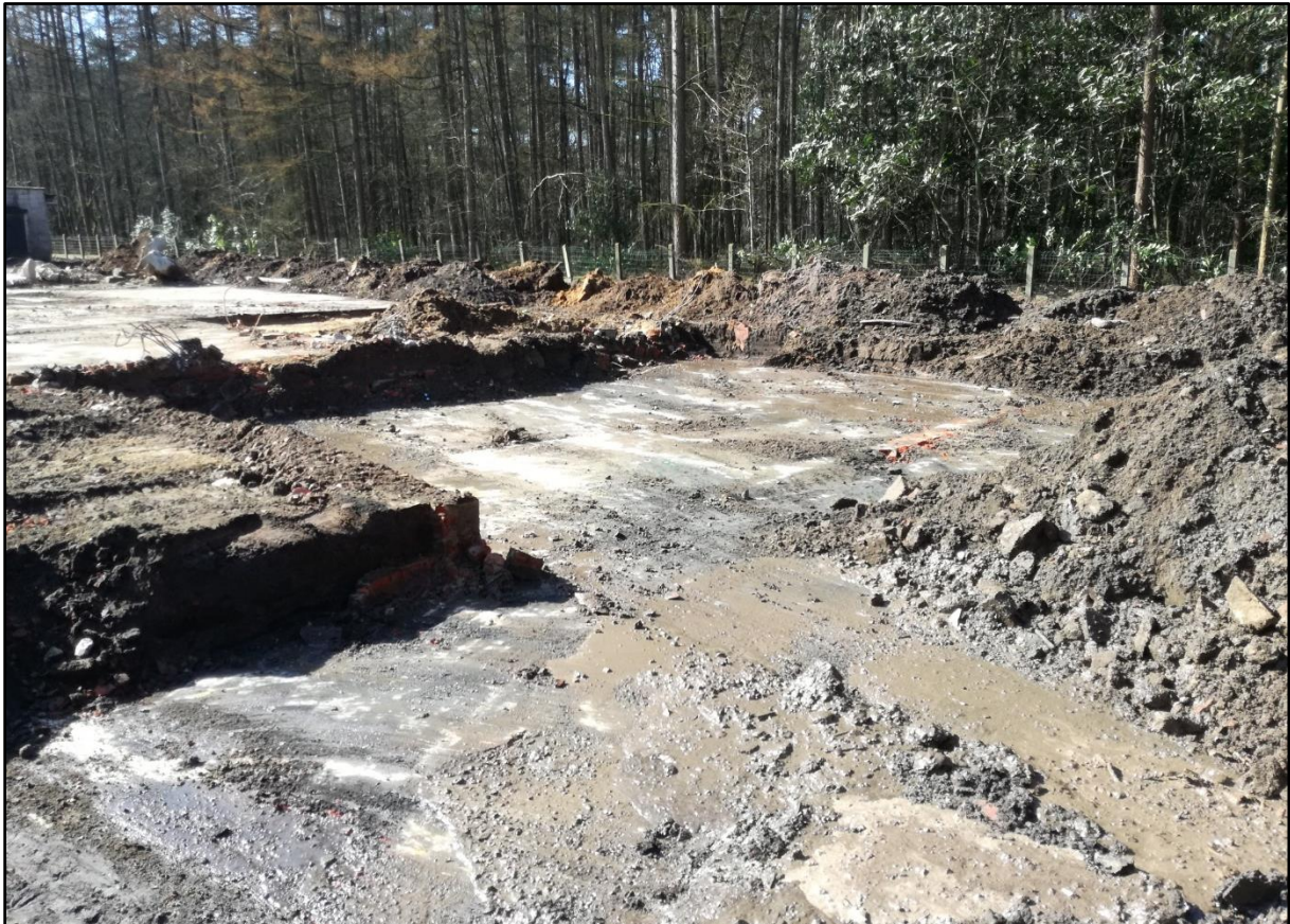
Figuur 8 Betonplaat onder de huidige betonplaat ter hoogte van de noordelijke zijde van het magazijn/tankstation.
