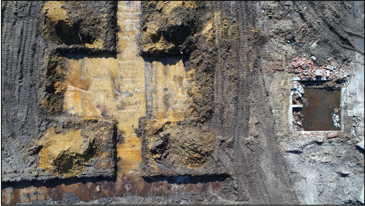
Figuur 25 Zicht op kijkvenster 2 ter hoogte van sleuf 4 (zone 2); rechts is de aanzet van het magazijn te zien.
