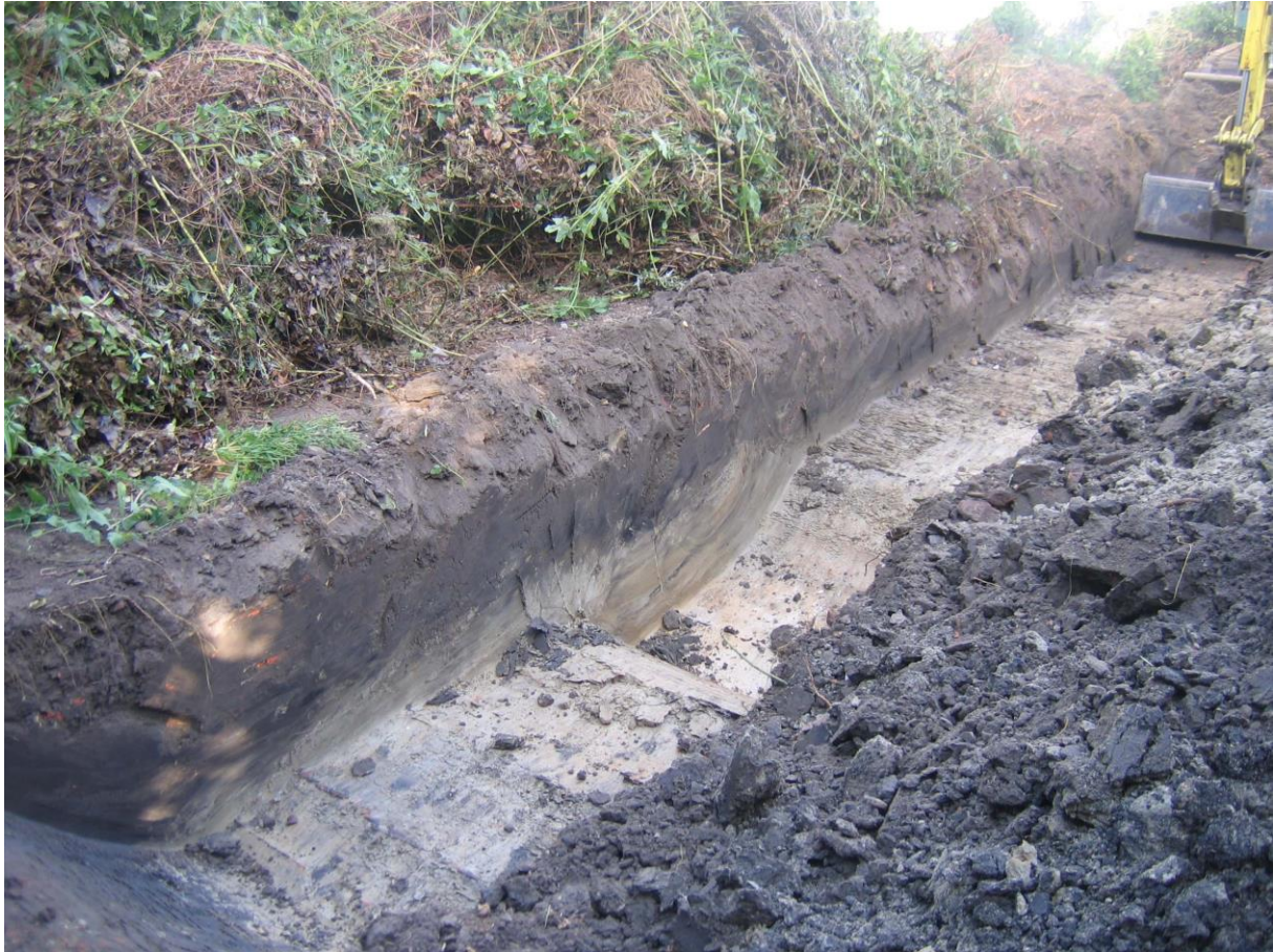
Figuur 29: Zicht op sleuf 14 (Huyghe, 2009)
