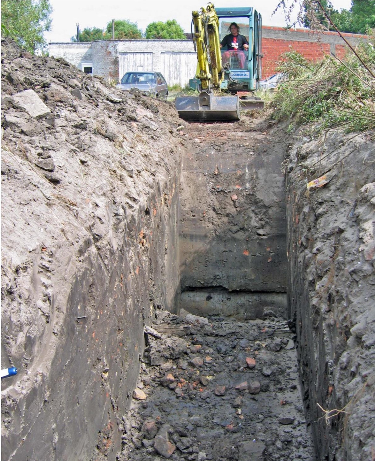
Figuur 28: Zicht op sleuf 13 (Huyghe, 2009)
