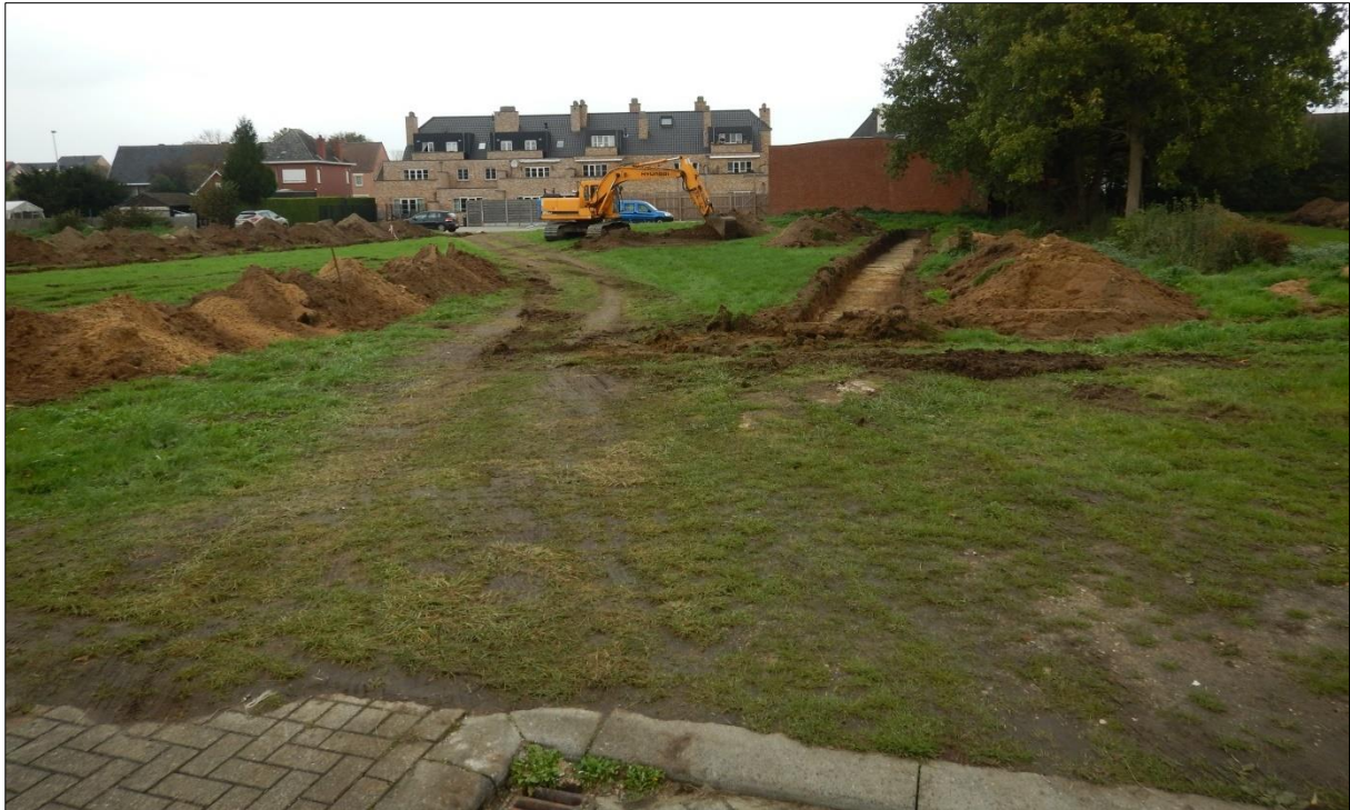
Figuur 28: De doorgang tussen de appartementen aan de Smissestraat en Gastenhuis moest gevrijwaard blijven waardoor sleuf 5 onderbroken werd. Door de aanwezigheid van noord-zuid georiënteerde bomenrij diende sleuf 6 ietwat westwaarts opgeschoven te worden.
