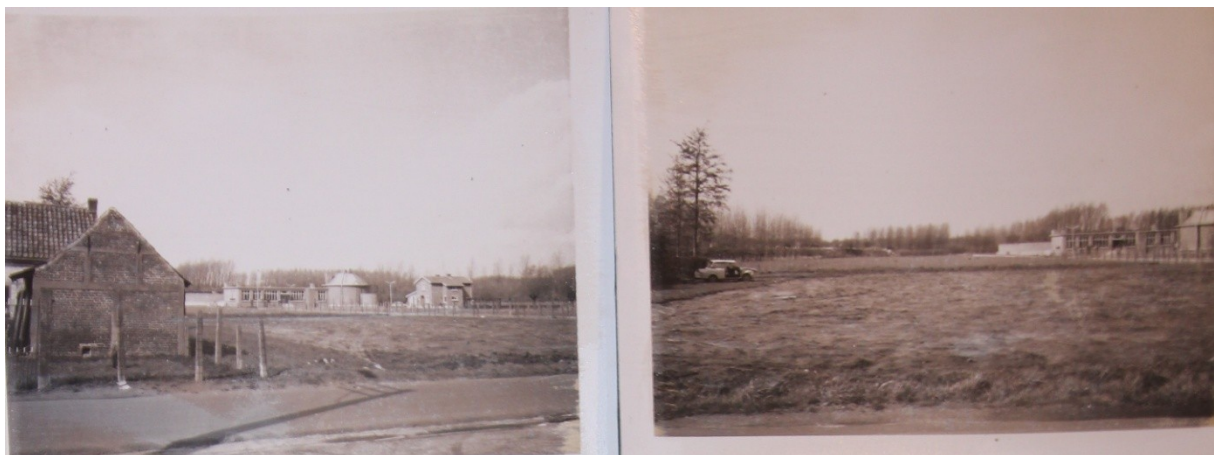
Fig. 10. Foto's van de bestaande toestand van de huidige locatie van Aldi (1972/41). Links is een deel van een hoevegebouw zichtbaar.
