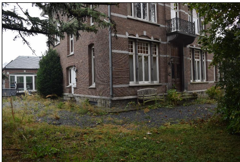
FOTO 22, Zicht op de zuidoostzijde van de notariswoning met verharding en kiezel errond. Foto genomen uit het zuidoosten (Aron bvba, dd. 10/10/2016, 2016H201)
