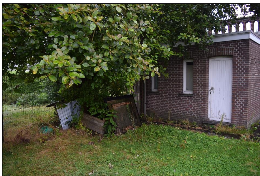
FOTO 18, Zicht op de noordwestzijde van de notariswoning en draadafsluiting achter de woning (links). Foto genomen uit het westen (Aron bvba, dd. 10/10/2016, 2016H201)
