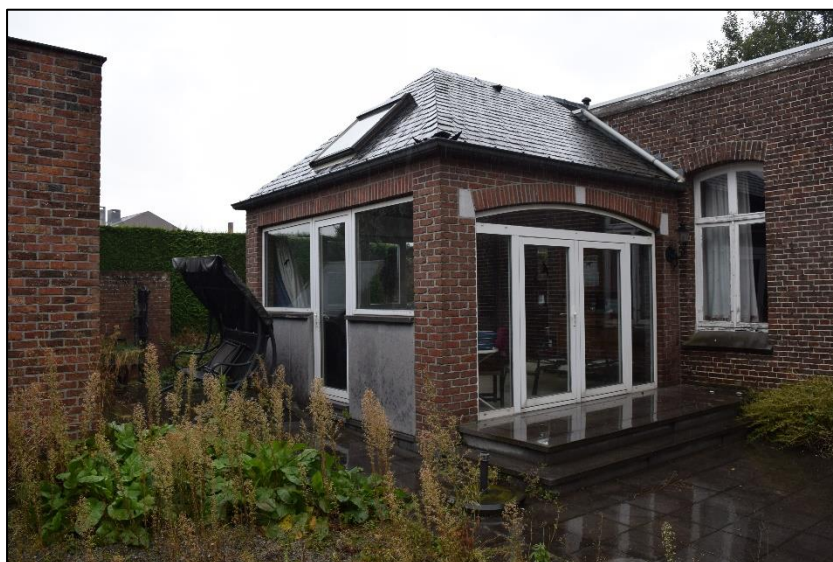
FOTO 14, Zicht op de zuidelijke aanbouw van de notariswoning met verhard terras (vooraan rechts) en op de garages in het zuidwesten van het terrein (links). Foto genomen uit het zuidoosten (Aron bvba, dd. 10/10/2016, 2016H201)
