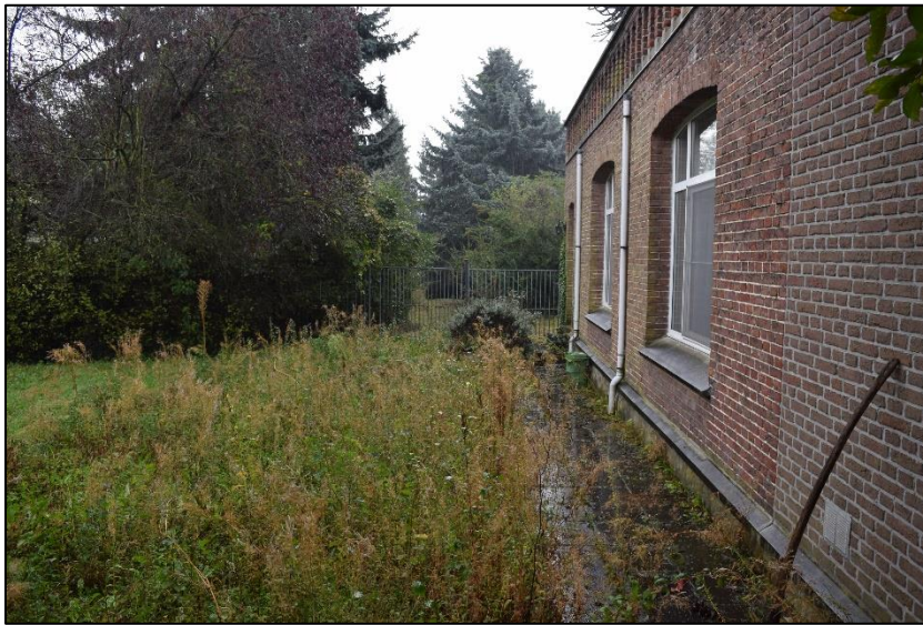
FOTO 19, Zicht op de noordzijde van de notariswoning (rechts) met verharding ernaast en braakliggend terrein. Achteraan zijn de hoogstammen in het oosten van het terrein zichtbaar. Foto genomen uit het noorden (Aron bvba, dd. 10/10/2016, 2016H201)
