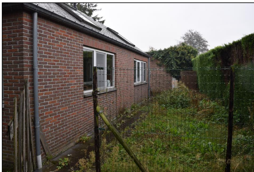
FOTO 16, Zicht op de haag die de westelijke grens van het terrein vormt (rechts) en op de westzijde van de notariswoning (links) en draadafsluiting achter de woning. Foto genomen uit het noorden (Aron bvba, dd. 10/10/2016, 2016H201)
