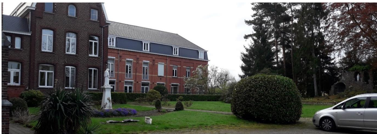
Foto 2 : Zicht op het noordelijk deel van het plangebied, ingericht als tuin met verharde oprit en parkeerruimte, gezien vanuit het noordwesten. (©BAAC)
