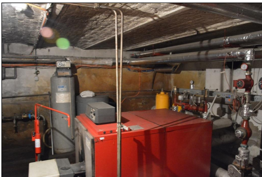
Figuur 8: Bestaande kelder van gebouw C 9
