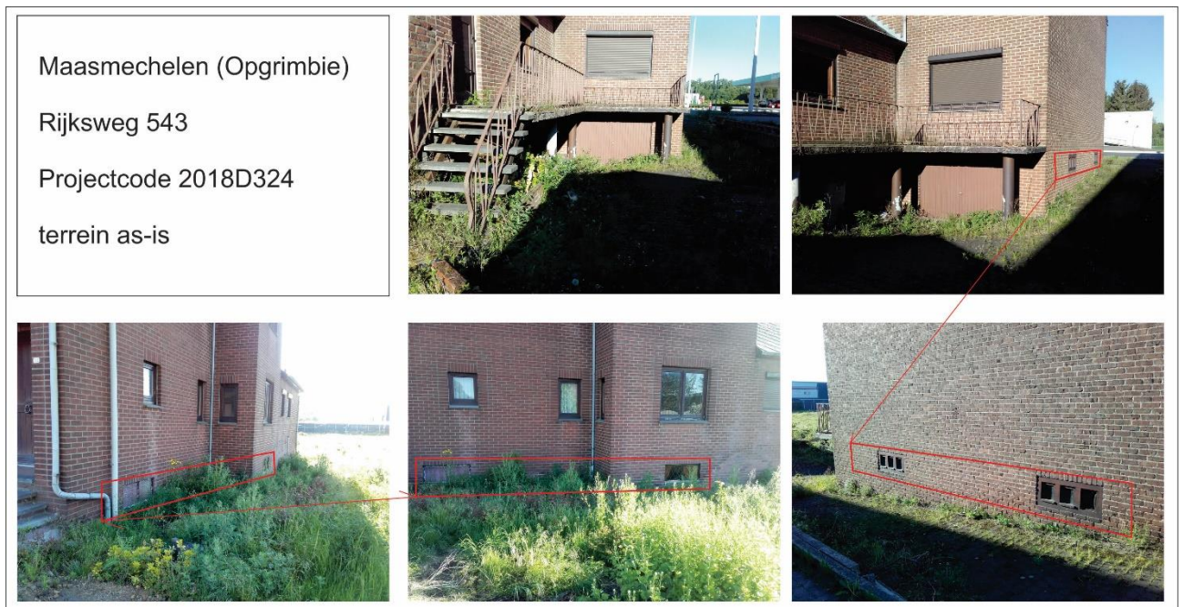
Fig. 2: de woning met huisnummer 543, actuele toestand en aanduiding van de kelders
