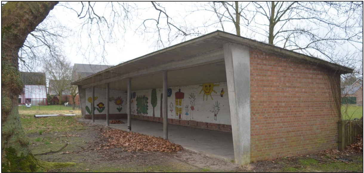
Afb. 38: Overdekte speelplaats ten zuiden van de speelweide (Bron: ARON bvba, dd. 23/03/2018, 2018C15).
