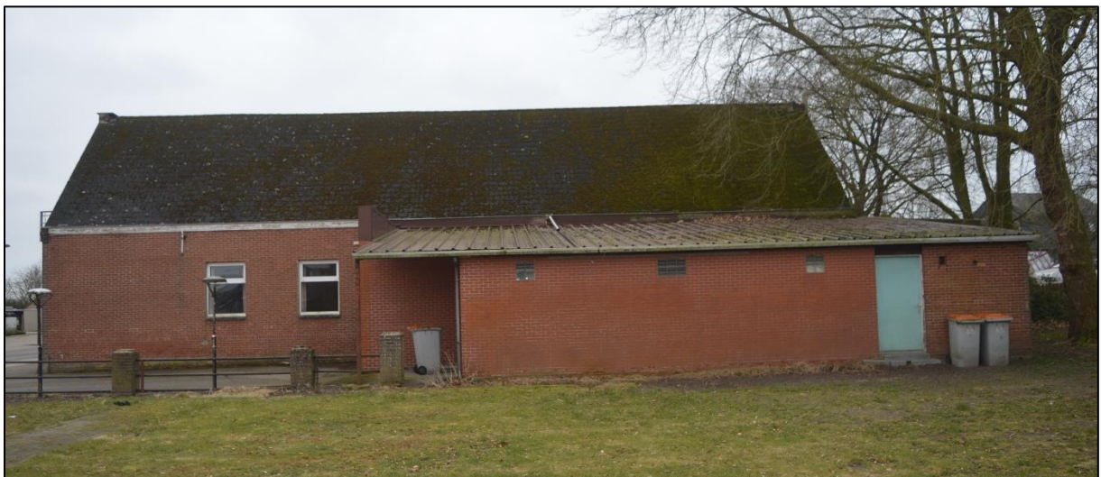
Afb. 39: Parochiecentrum ten noorden van de speelweide met aangrenzende braakliggende tuin (Bron: ARON bvba, dd. 23/03/2018, 2018C15).
