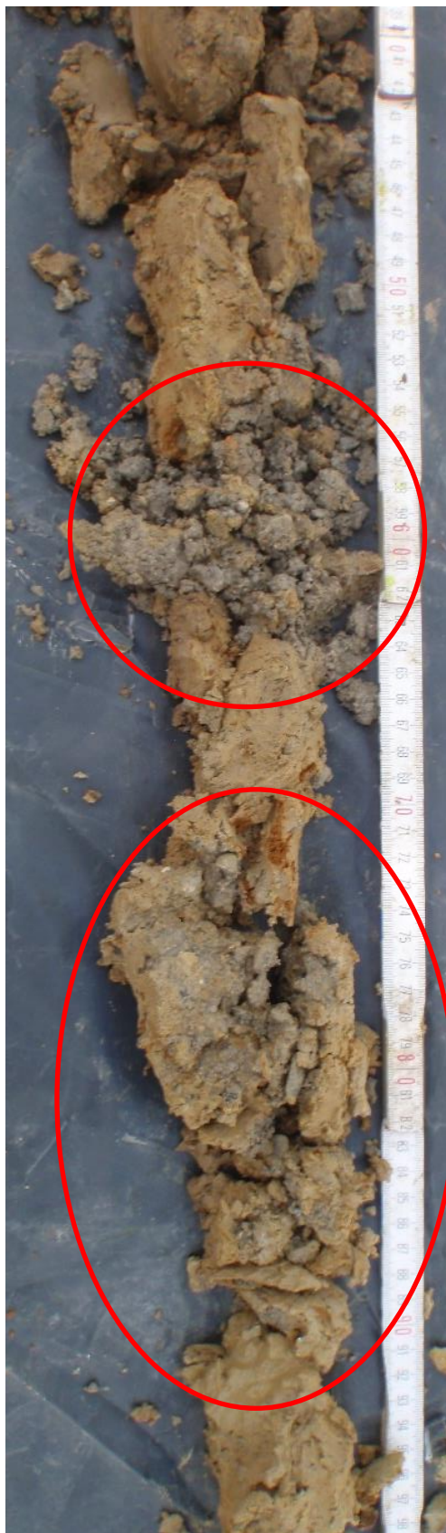
Foto 9: Close-up controleboring 4 met aanduiding van het betonpuin (© J. Verrijckt Bvba)
