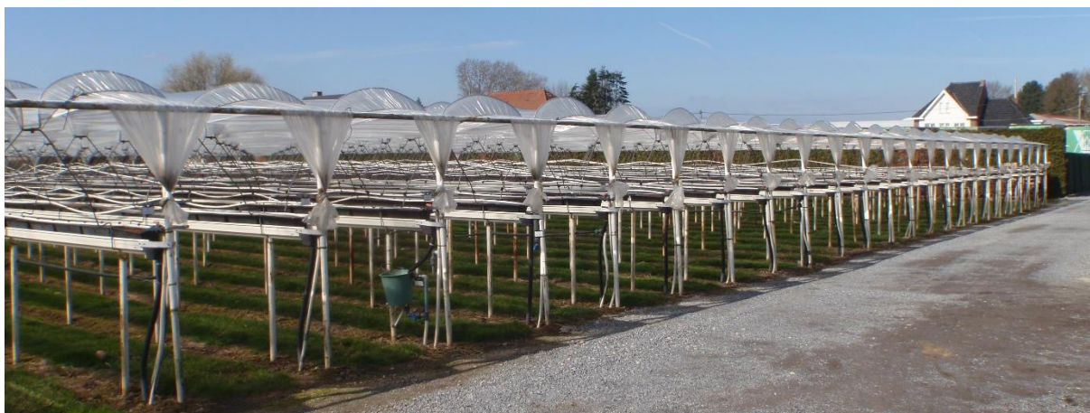
Figuur 5: Zicht op de overkappingen (© J. Verrijckt Bvba)
