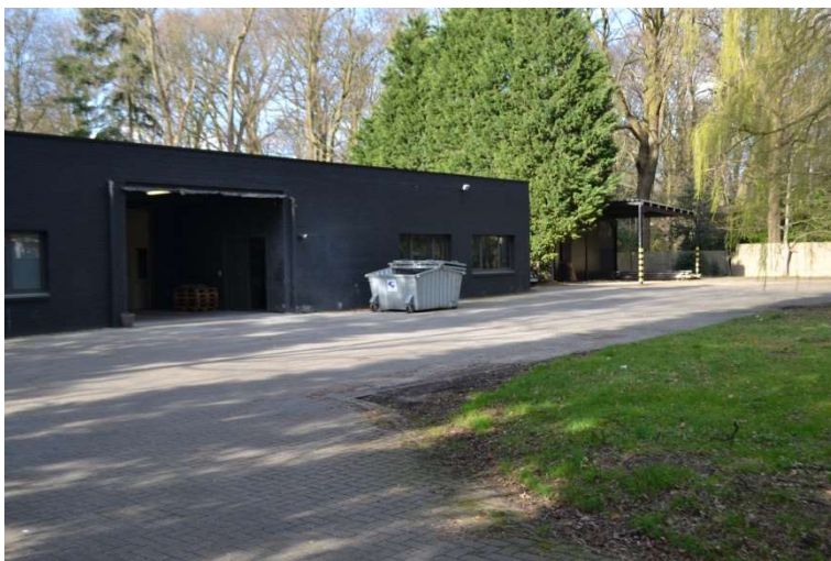
c. Zicht op de huidige bebouwing vanaf de toe- gangsweg: op de voorgrond het magazijn, op de achter- grond de loods.
