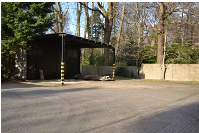
d. Detailzicht op de loods met laadzone.
