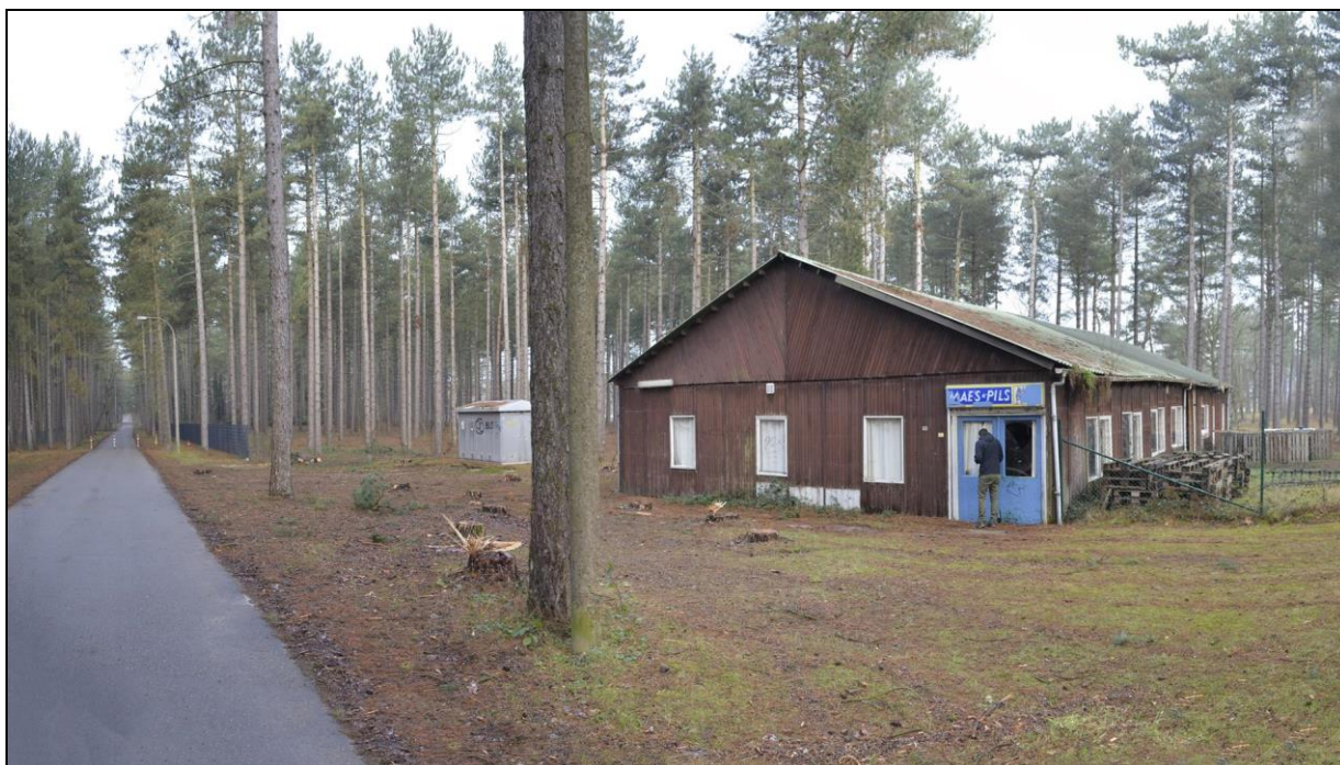
Afb. 6: Zicht op het terrein met vooraan het bestaande gebouw en achteraan de HS-cabine, zicht uit het zuidoosten (foto initiatiefnemer, 11/01/2018).
