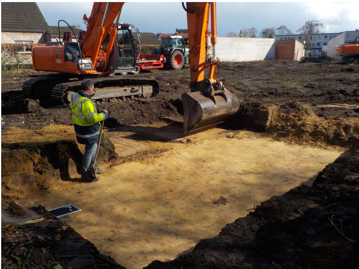
Figuur 11. Aanleggen van de uitbreiding van proefsleuf 4.
