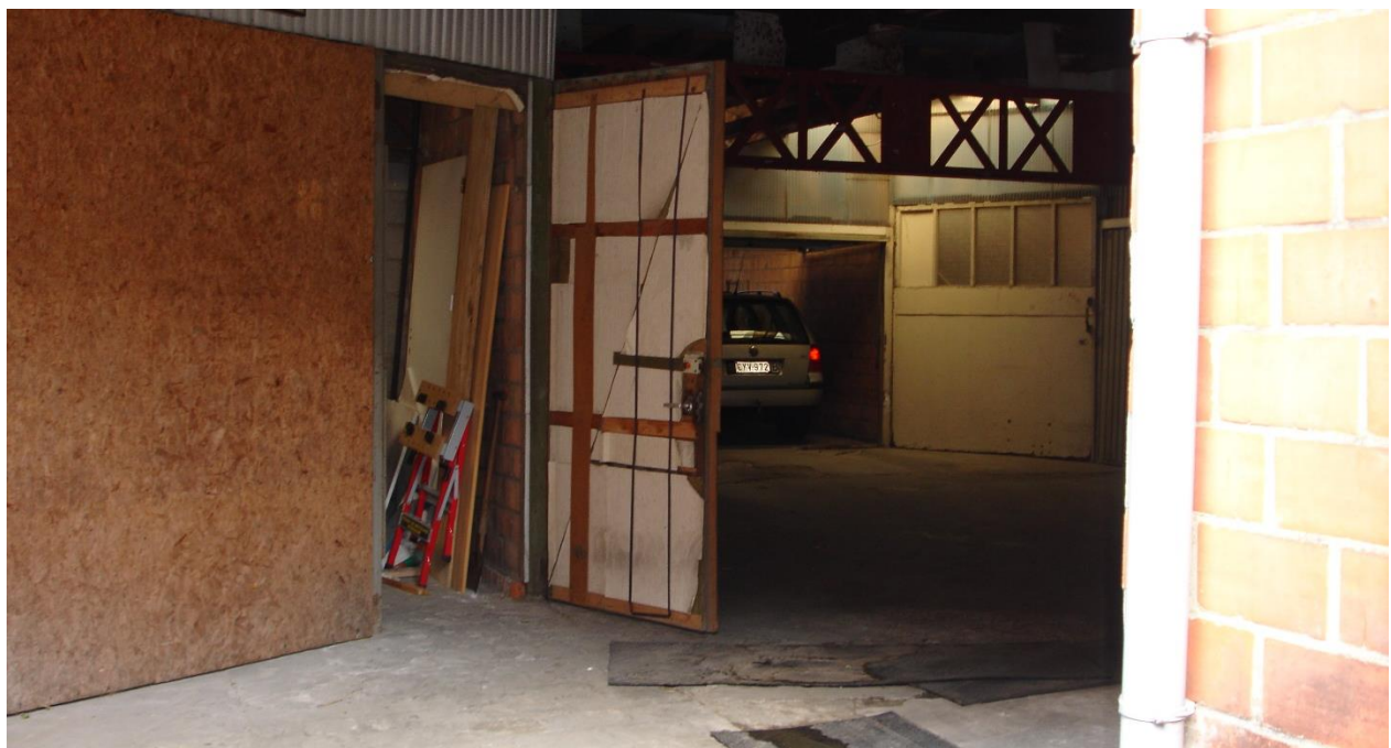
Figuur 5: zicht op de parkeerplaatsen en garageboxen vanaf de doorrit. Situatie voor de afbraak van de bedaking
