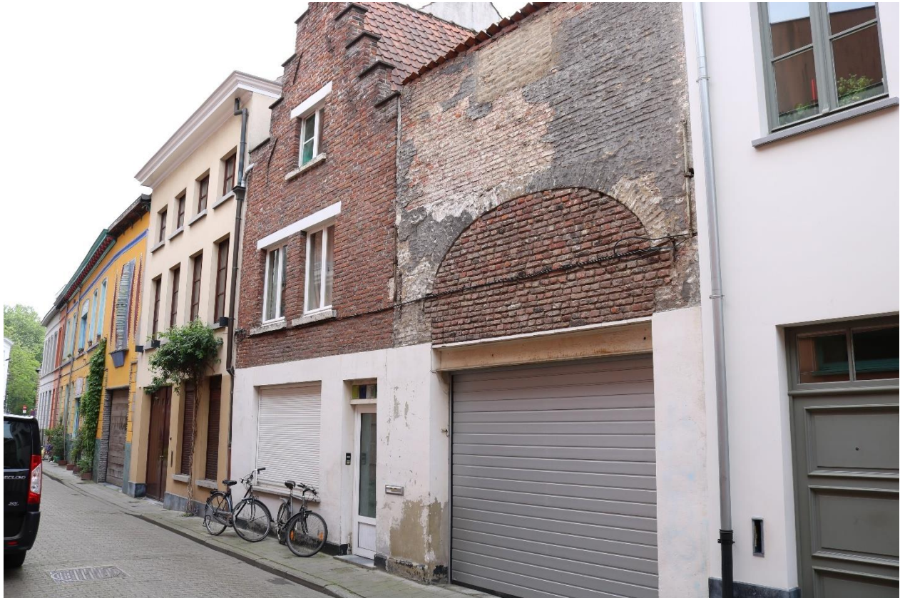
Figuur 4: zicht op woning en doorgang vanaf de Oudevest
