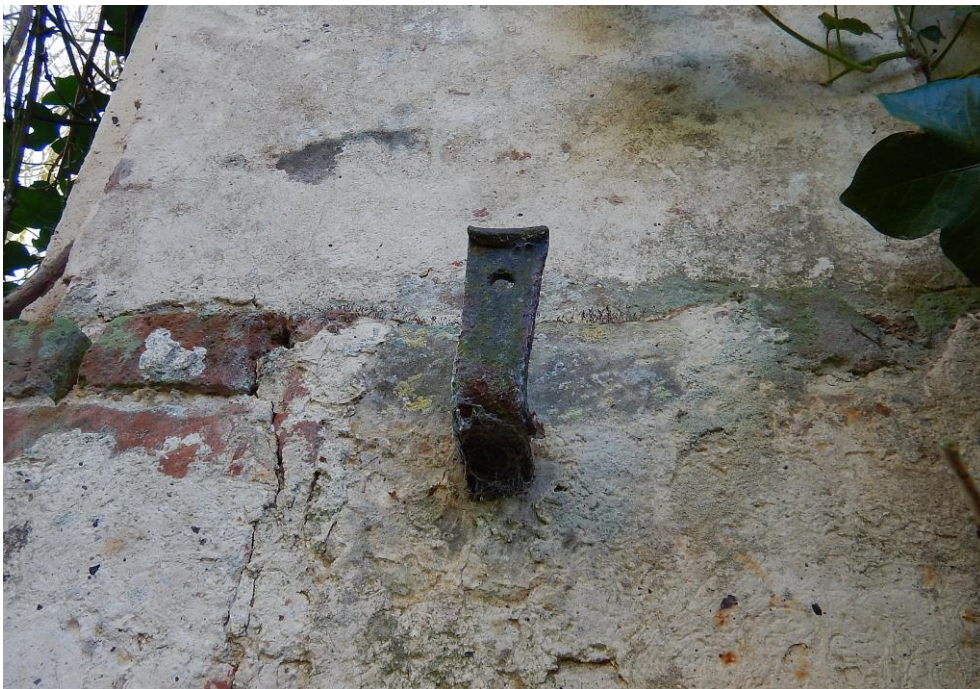
Figuur 22. Ijzeren haak voor loopplanken (@Hembyse).
