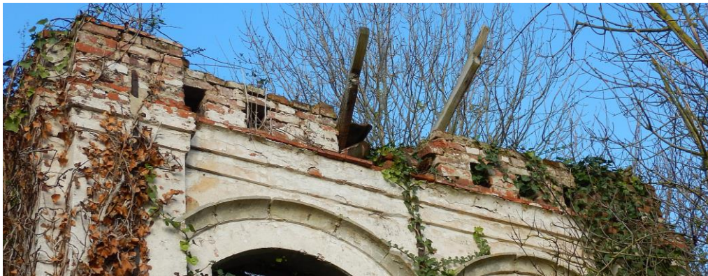
Figuur 28. Een detail van de overgang tussen de tweede bouwlaag en de borstwering met vliegopeningen. Bemerkt het verschil in kwaliteit van bepleistering (@Hembyse).
