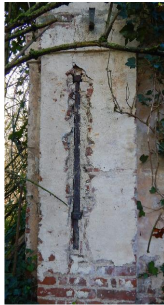
Figuur 25. De zuidzijde en de oostzijde van de duiventoren, met één zichtbaar muuranker (©Hembyse).
