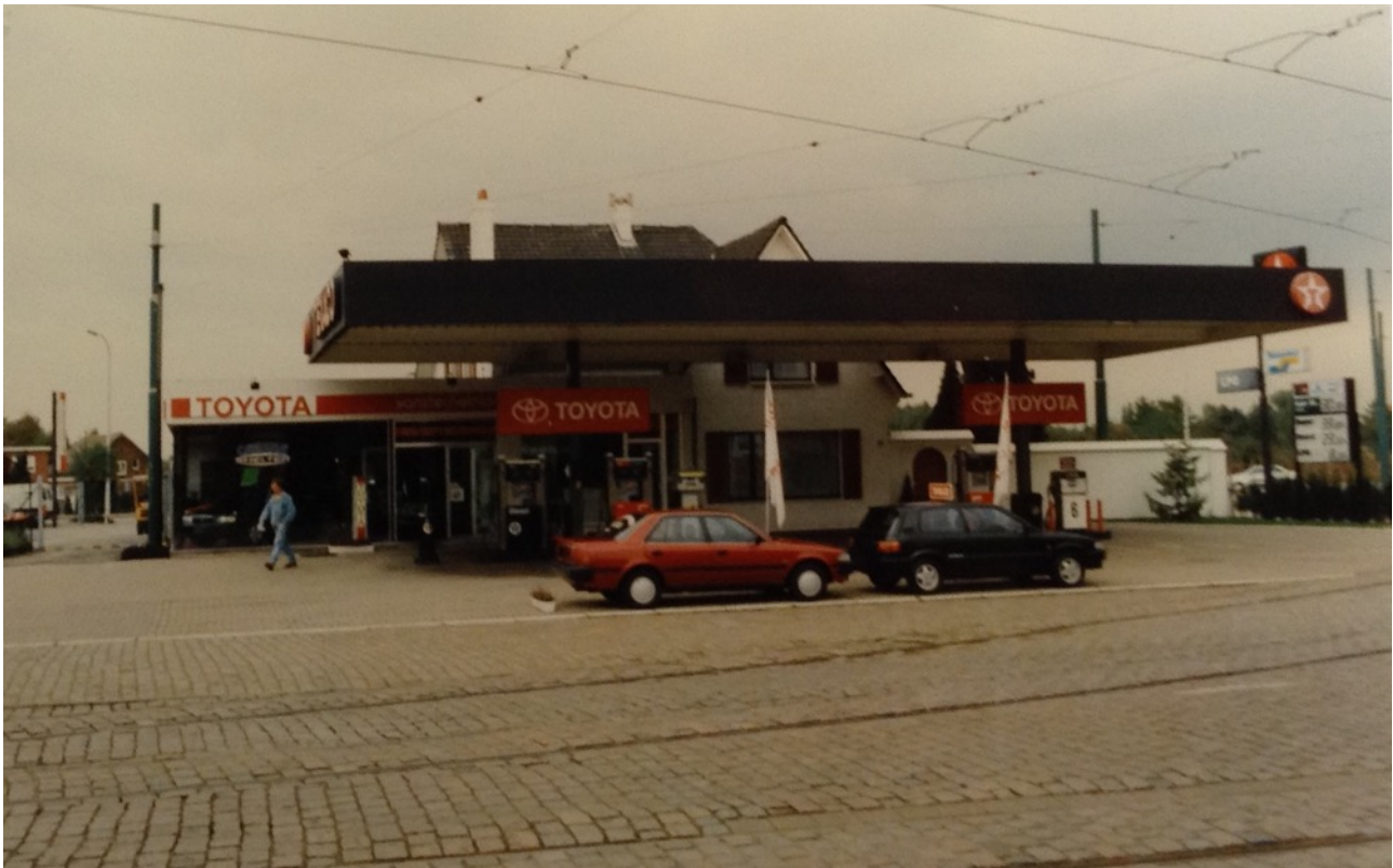
Fig. 19 FOTO4. Vooraanzicht van het tankstation annex garage en woonhuis. Bestaande toestand na de verbouwingen van 1985 zoals weergegeven in de bouwaanvraag van 1996 © Felixarchief 629#2290 van 1996
