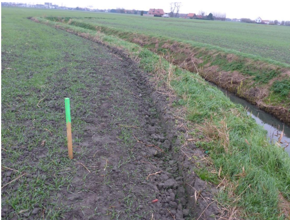
Figuur 4 : zicht op te smalle werkzone
