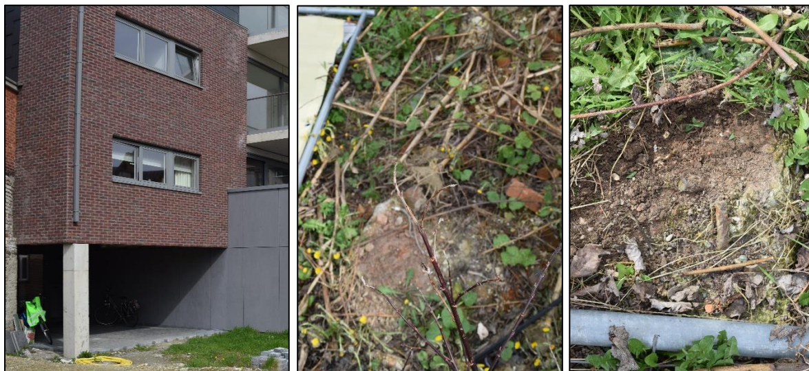
Afb. 42 – 44: van links naar rechts: verharde zone van 60 m 2 waar een verharde inrit ligt en 2 paalfunderingen diameter 60 cm, diepte ca. 12 m, gelegen in het noordoosten van het terrein (Bron: Aron bvba, dd 09/04/2018, 2017F268).
