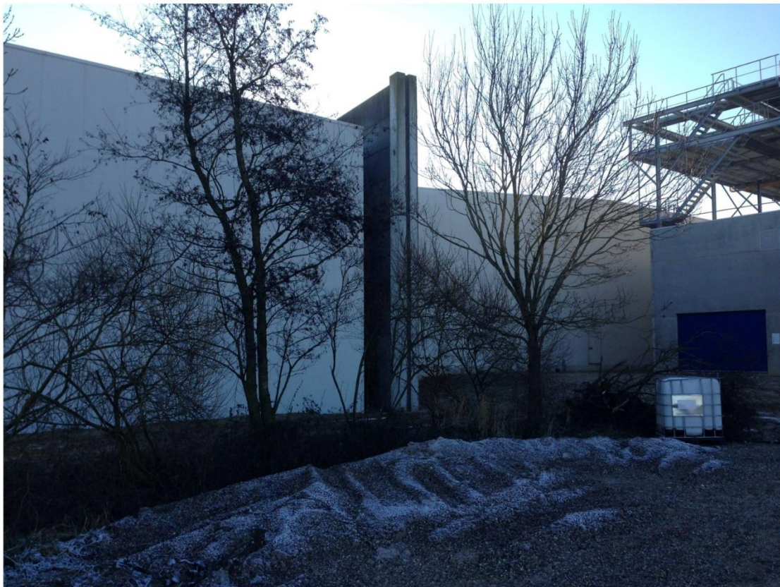
Figuur 1. Zicht op vorige bouwfase.
