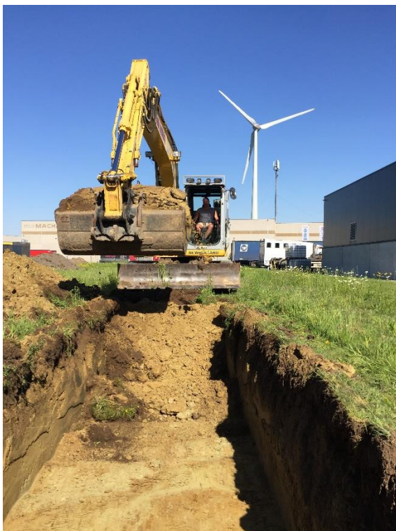
Figuur 4. een 21-tons rupskraan met een tandeloze graafbak van 1,80m
