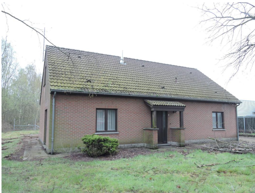
Afb. 4. Het oude woonhuis: detail 1.
