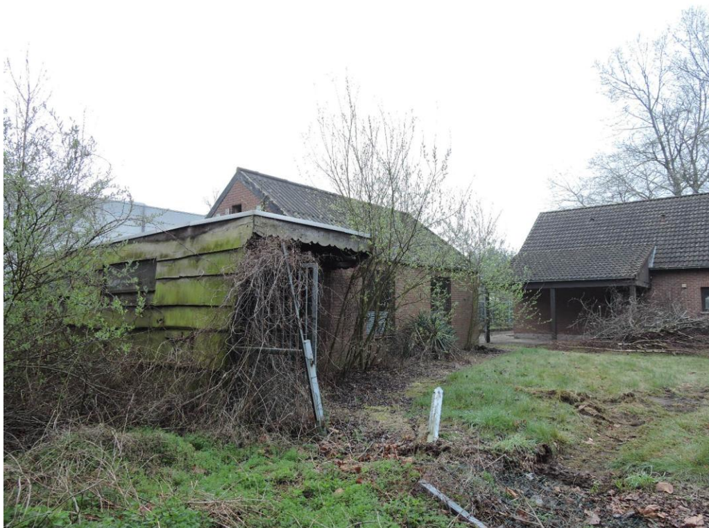
Afb. 5. Het oude woonhuis: detail 2.
