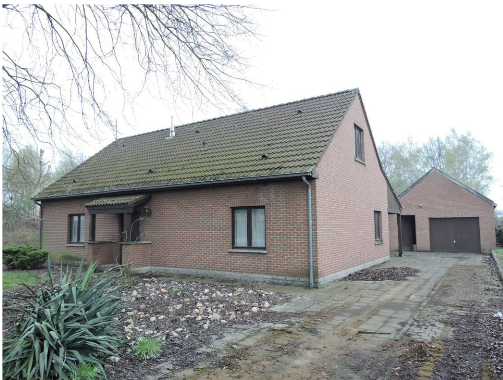
Afb. 6. Het oude woonhuis: detail 2.
