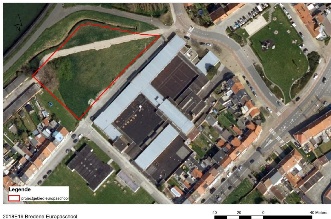
Figuur 18 : Orthofoto genomen in de periode 2015 ter hoogte van het projectgebied (© Geopunt). Hierop is duidelijk de werfweg/werfzone zichtbaar ter hoogte van de voormalige gracht.
