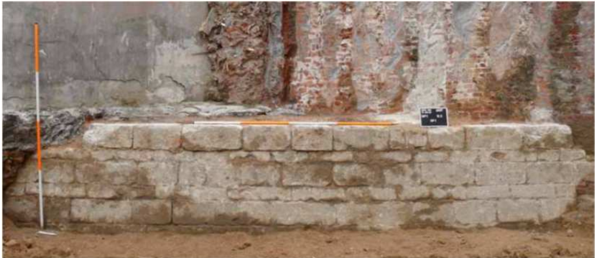
Figuur 37: Opgegraven muurdeel van bastion Kipdorp met zicht op het natuurstenen parement. Op de achtergrond staan links de grijs gecementeerde muur van het zuidelijk buurhuis, met onderaan de weggebroken betonnen keldervloer en rechts de secans palenwand met restanten van oud metselwerk op het oppervlak, dat behoort tot de bakstenen kern van de muur van de omwalling (Bron: Fodio, SIAM 15, 2016).
