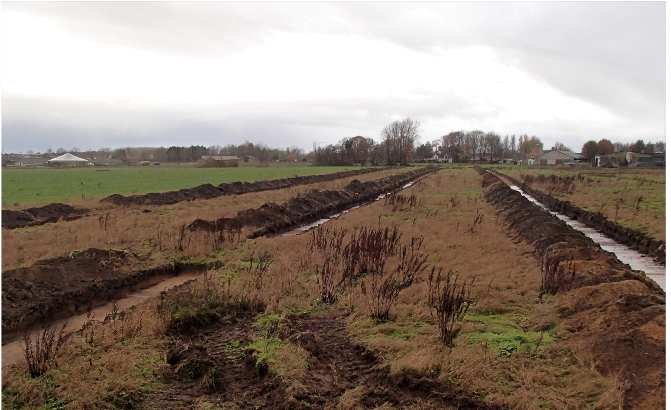
Figuur 57: De proefsleuven in het noordelijk deel van het plangebied, foto genomen vanuit het zuiden.
