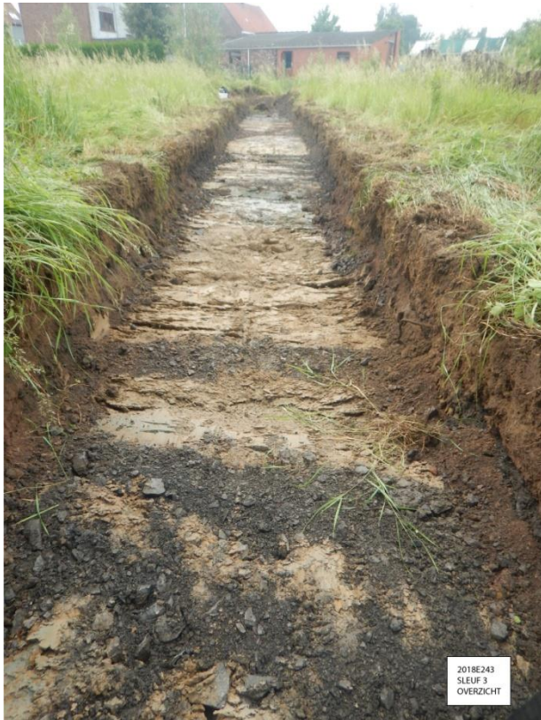
Figuur 43. Grote verstoringsgraad aan de noordelijke kant van sleuf 3.
