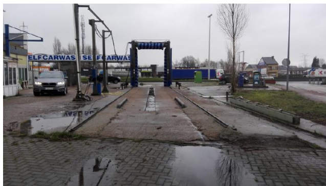
Figuur 6: zicht op car-en truckwash, op perceel 12s richting Boomsesteenweg (bron: Artemis milieu 2017)
