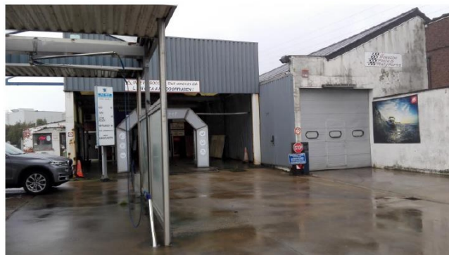
Figuur 4: Zicht op luifel, carwash en poort van autowerkplaats op perceel 12s (bron: Artemis milieu 2017)
