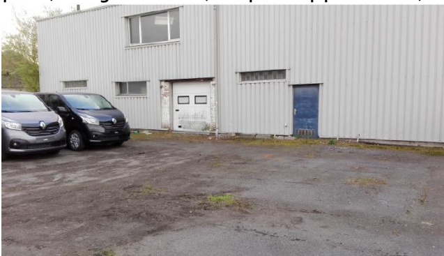
Figuur 8: Zicht op autostaanplaats, perceel 11d (bron: Artemis milieu 2017)
