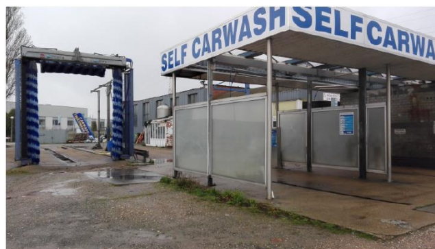
Figuur 5: Zicht op truckwash en luifel, perceel 12s (bron: Artemis milieu 2017)
