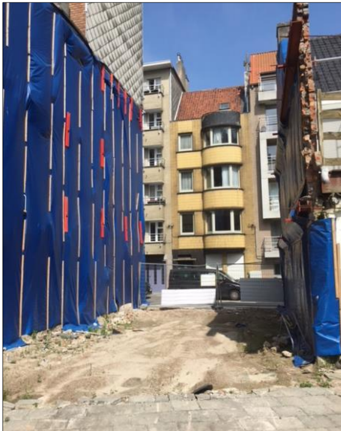
Figuur 5: Huidige toestand terrein, huisnummer 3 na sloop (bron: opdrachtgever).
