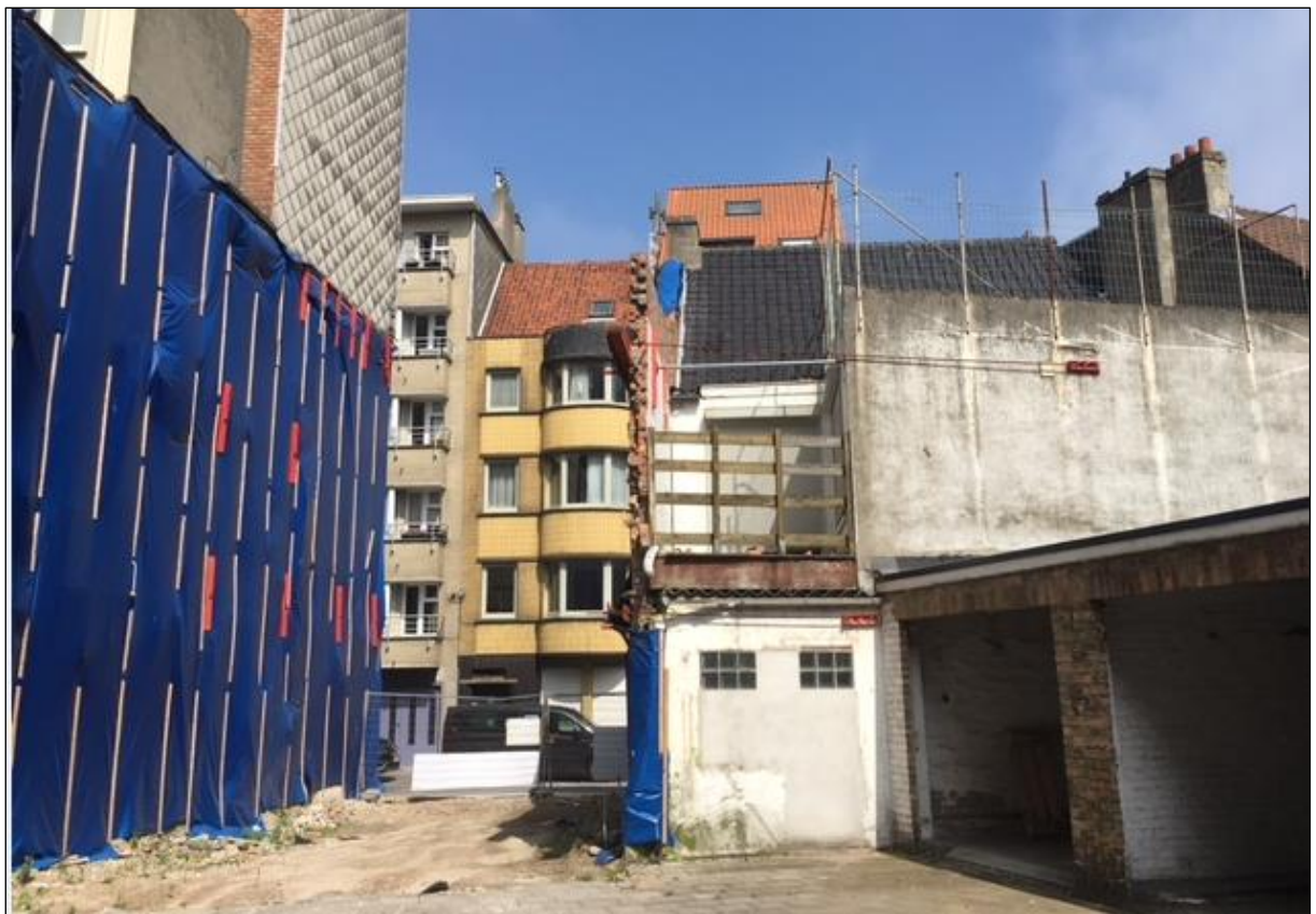
Figuur 6: Huidige toestand terrein: foto genomen van de westzijde (bron: opdrachtgever).
