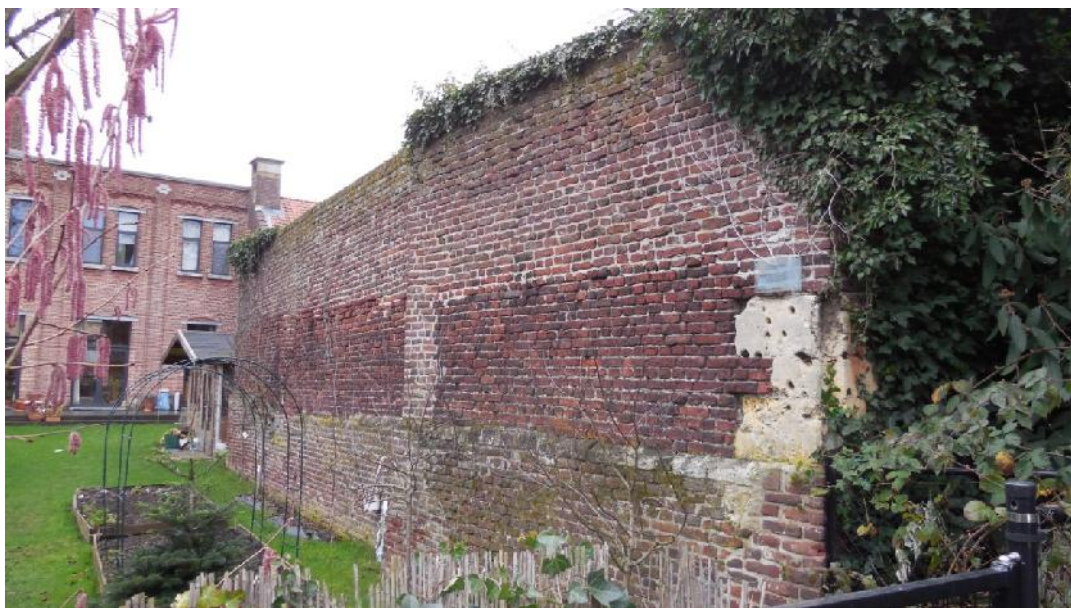
Afbeelding 37: Zicht op de restanten van de vestingmuur en bastion.
