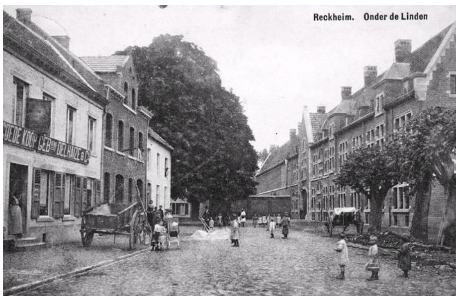
Afbeelding 40: Zicht vanop Onder de Linden naar het noorden (Groenplaats) toe. Achteraan is de muur en een gebouw te zien.
