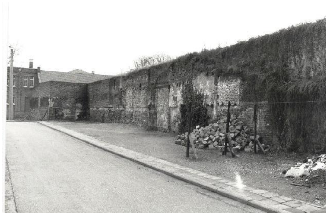
Afbeelding 42: Zicht vanuit de Schiefstraat naar het oosten toe, met rechts de stadsmuur met bastion.
