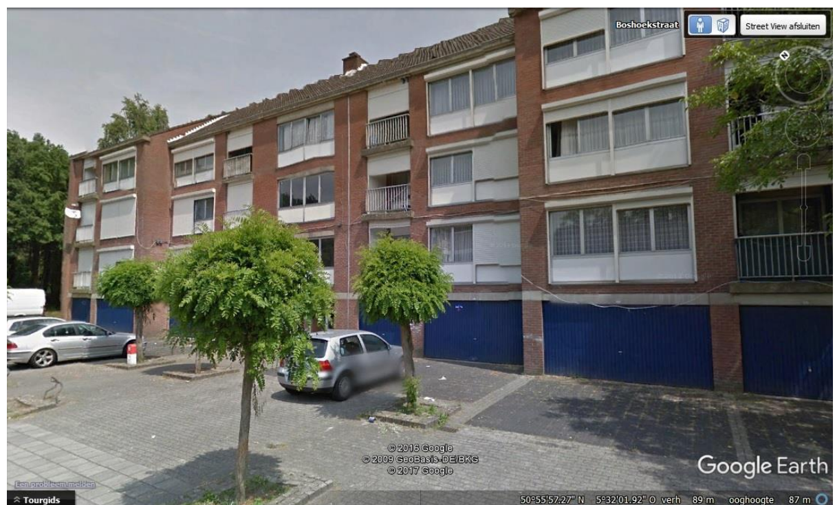
Fig. 5 Voorzijde van het noordelijke gebouw (juli 2013). © Google Street View
