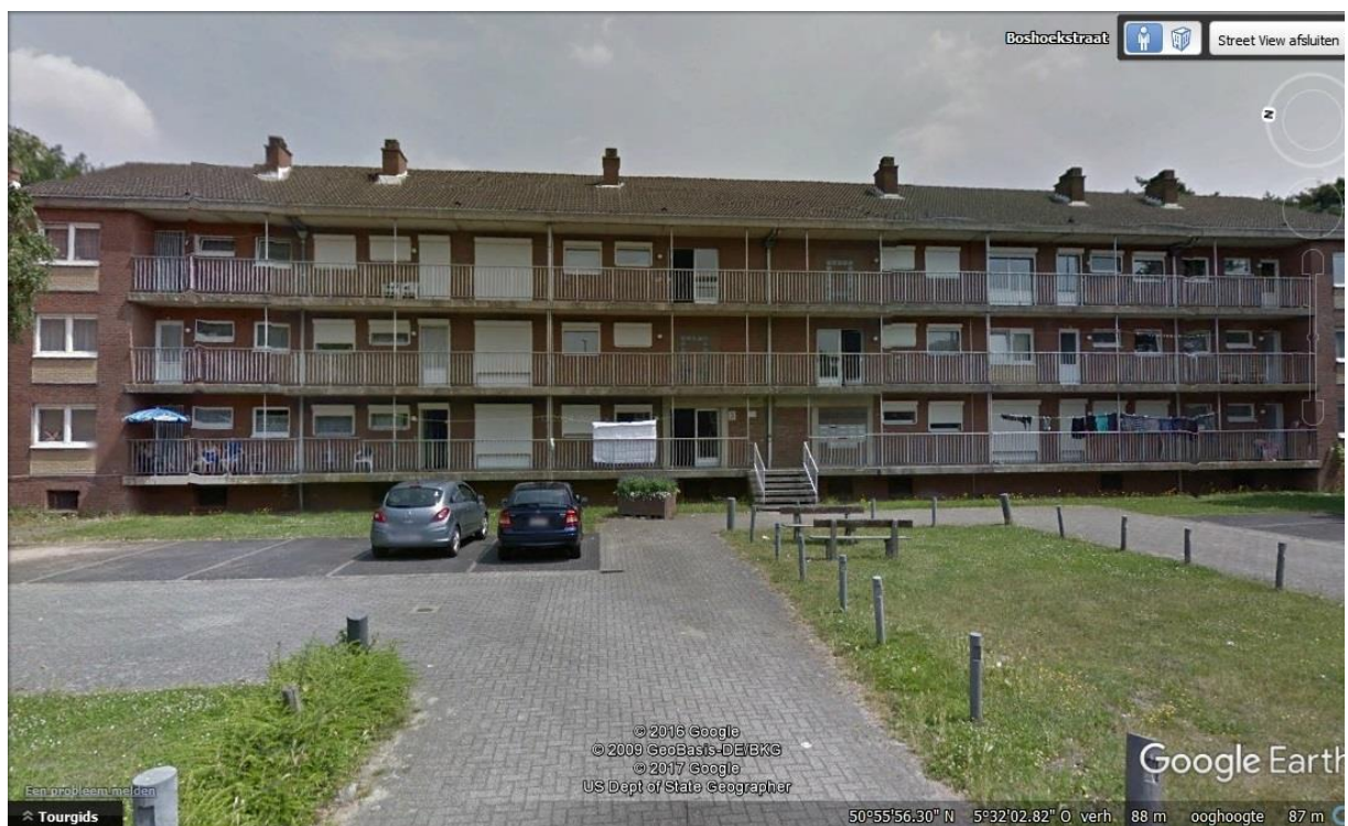
Fig. 7 Voorzijde van het middelste gebouw (juli 2013). © Google Street View
