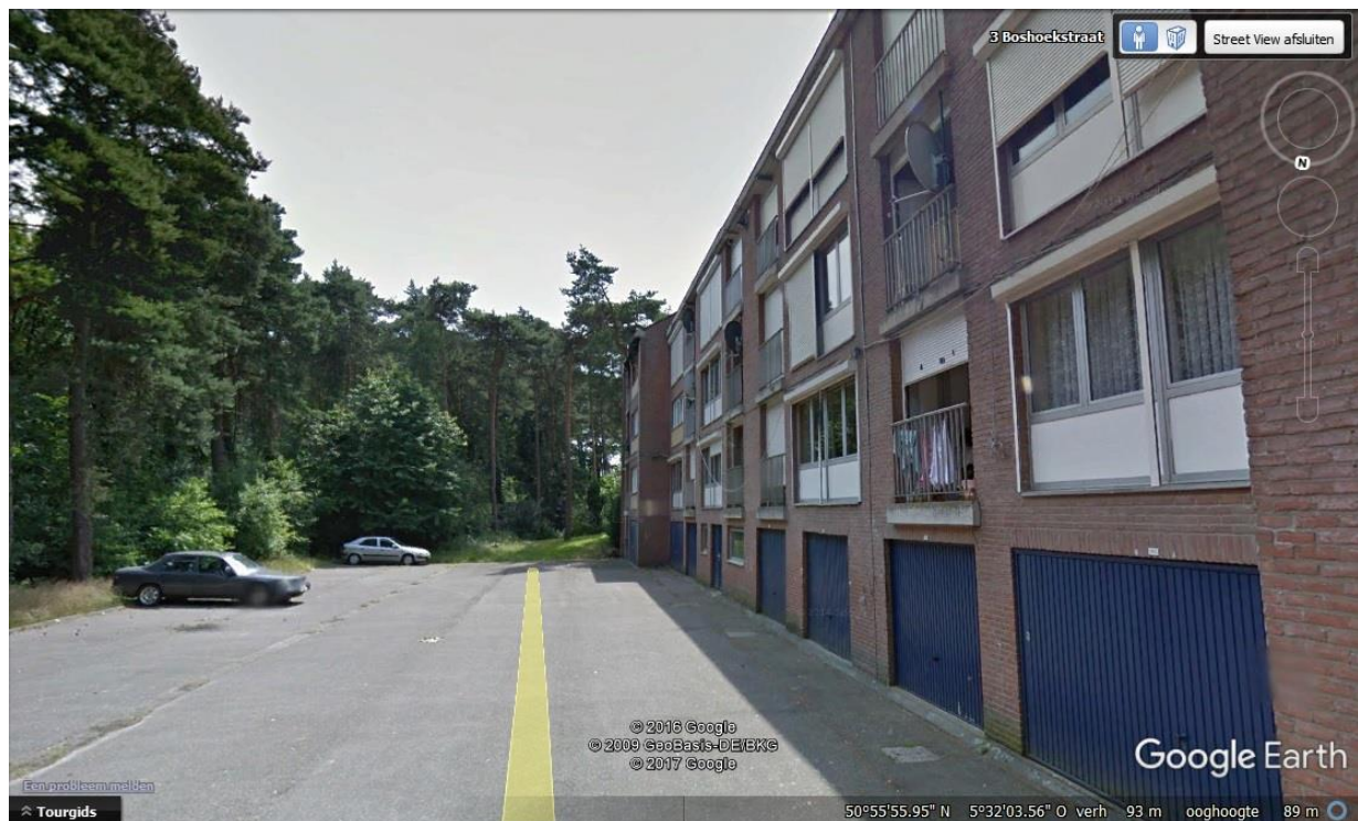
Fig. 6 Achterzijde van het middelste gebouw (juli 2013). © Google Street View
