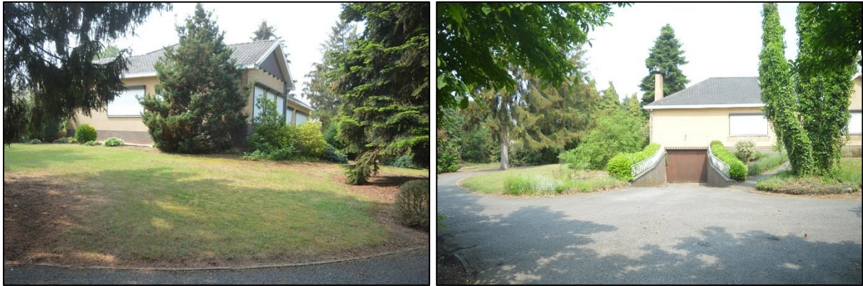
Afb. 28: Centraal gelegen woonhuis, dat gebouwd is op een ophoging en onderkelderd is (Bron: Aron bvba, dd. 29/05/2018, 2018E270).
