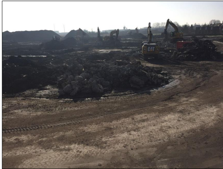
Figuur 10: Foto van de suikerfabrieksite genomen tijdens de sloopwerken. (©ION)
