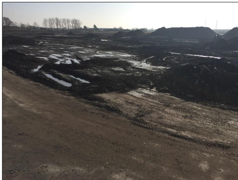
Figuur 11: Foto van de suikerfabrieksite na het slopen van de fabrieksgebouwen (©ION)
