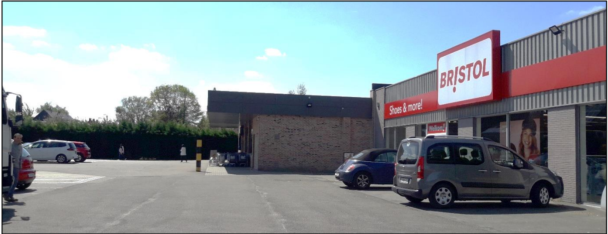
Foto 2 : Zicht op het noordoostelijk deel van het plangebied ingericht als verharde parkeerruimte ter hoogte van boring 2, gezien vanuit het noorden. (©BAAC)
