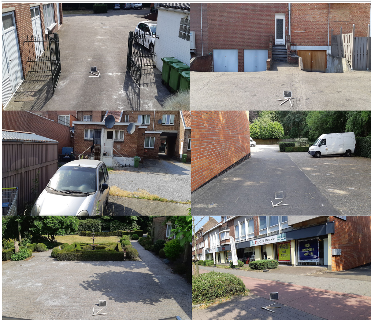
Fig. 1.14: Zicht op de bebouwing in de noordelijke helft van het terrein.
