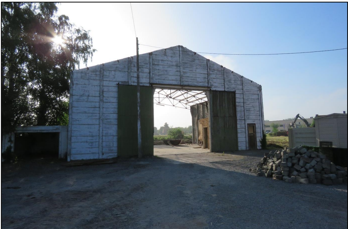
Figuur 2 Zicht op grotendeels afgebroken loods in het noordoosten.
