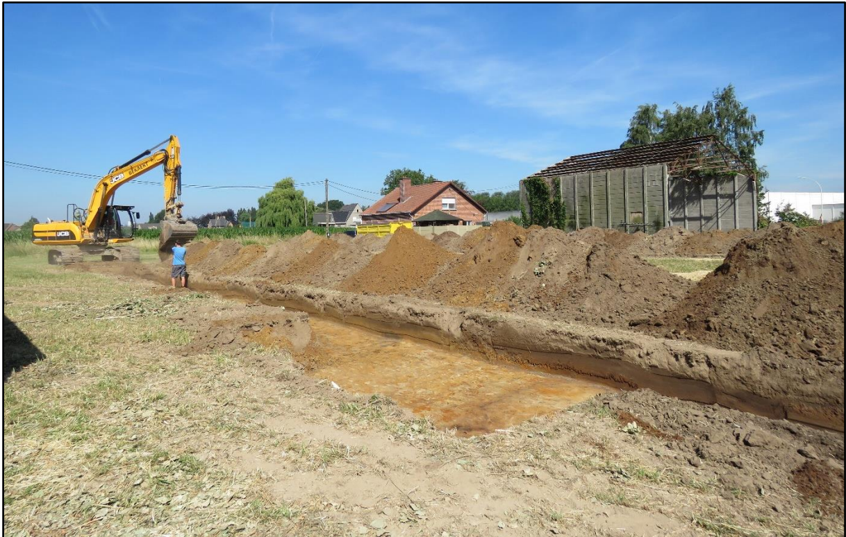
Figuur 11 Aanleg van sleuf 5 met kijkvenster.
