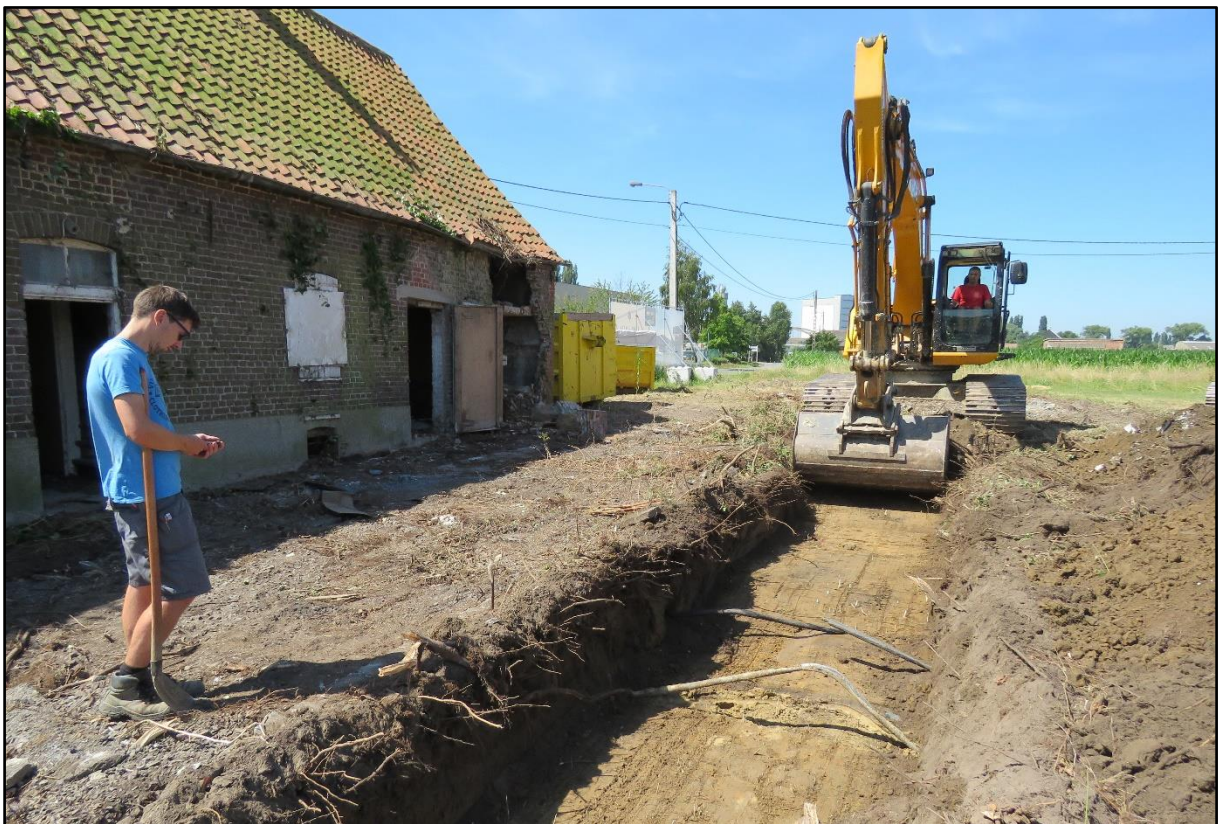
Figuur 12 Aanleg van sleuf 7 met diverse verstoringen.
