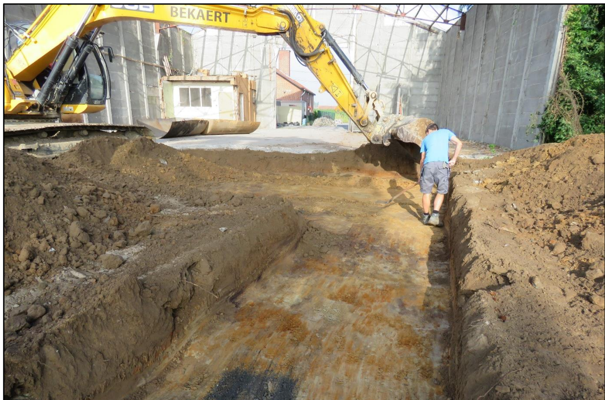
Figuur 8 Sferbeeld tijdens de aanleg van sleuf 1 met ruim kijkvenster.
