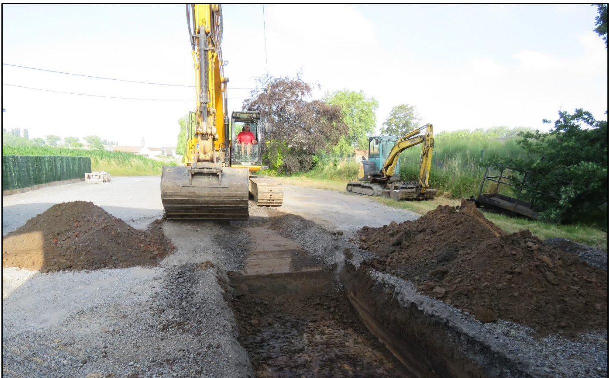
Figuur 10 Aanleg van sleuf 3 ter hoogte van de inrit met steenslag (gescheiden afgraving).
