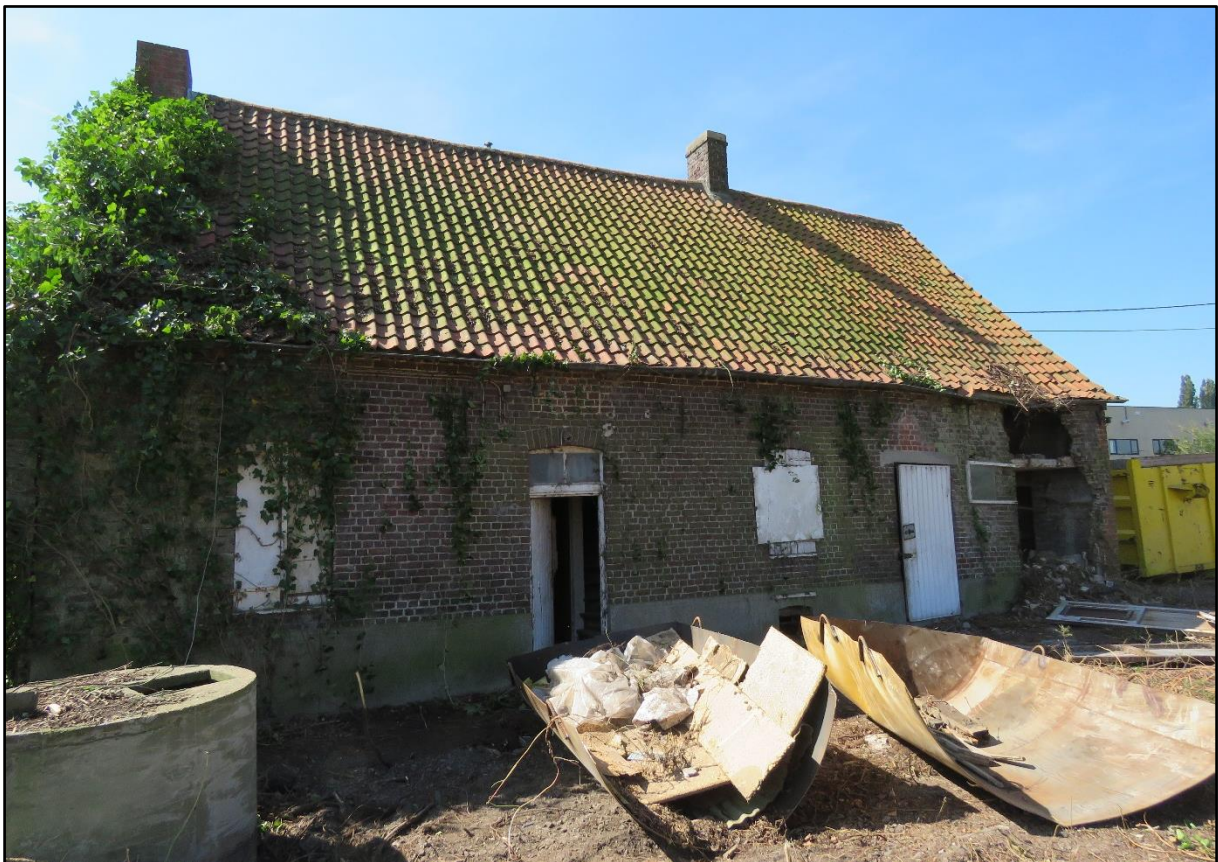
Figuur 4 Zicht op de leegstaande woning, alle omliggende obstakels werden afgebroken tot op maaiveldniveau.
