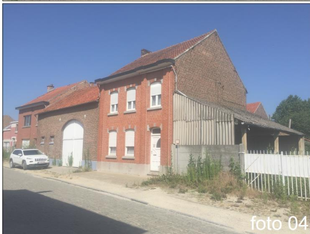
Figuur 3: Zicht op de te slopen gebouwen langs de 3de Regiment Lansiersstraat. 12 Boven: zicht op huisnummer 42 vanuit zuidwestelijke hoek van het plangebied. Onder: zicht op huisnummer 40 vanuit zuidoostelijke hoek van het plangebied.
