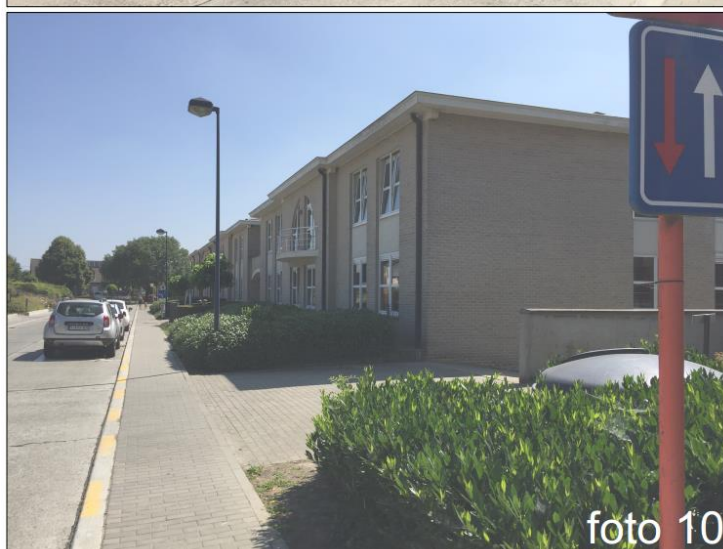
Figuur 1: Zicht op het woonzorgcentrum langs de Helen-Bosstraat vanuit noordoostelijke (foto 8 en 9) en noordwestelijke hoek (foto 10). 10
