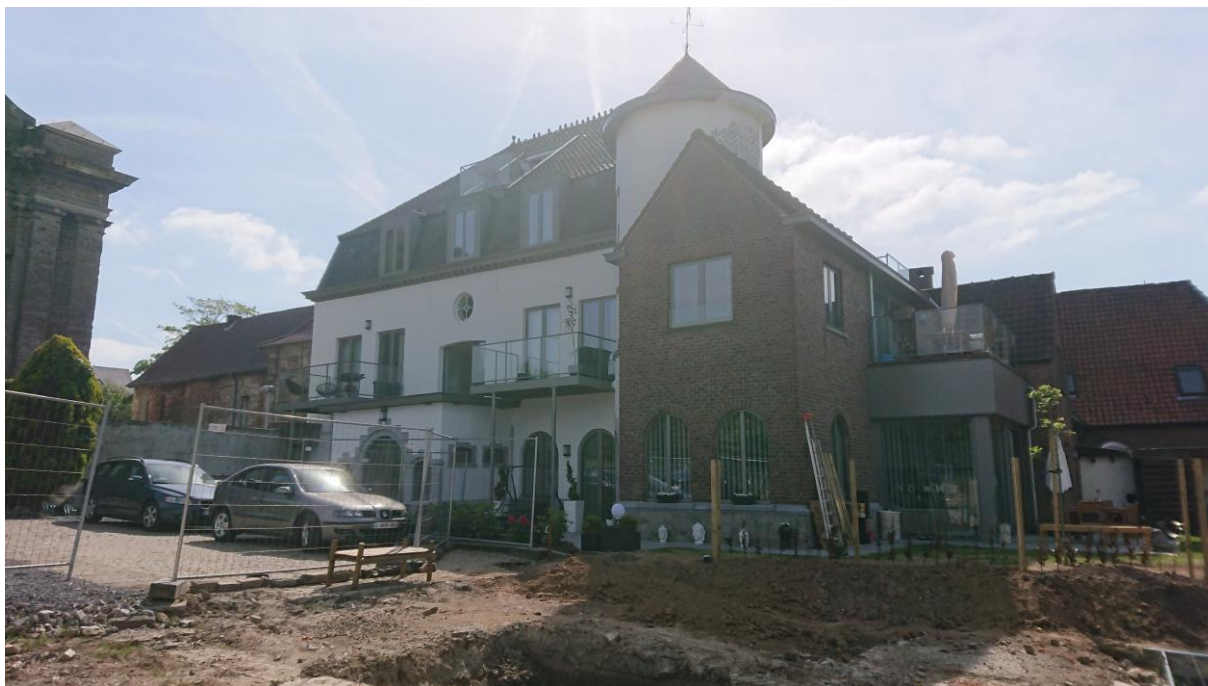
Foto 3: langsgelegen (beschermd) appartementsgebouw
